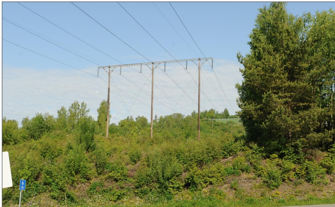
Figur 7-1: Eksisterende 132 kV ledning mellom Dokka og Gjøvik.
