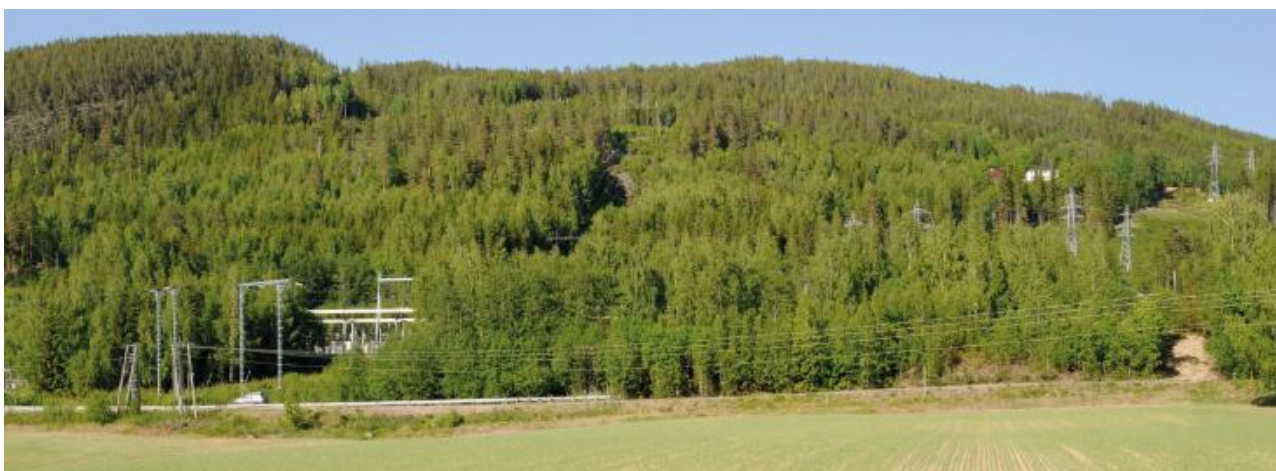
Figur 7-9: Utsikt nordøstover fra Dokka transformatorstasjon. Dagens situasjon
