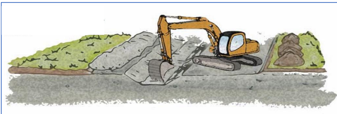
Figur 10-9. Massene som graves ut med gravemaskin legges opp langsmed kabelgrøfta.
