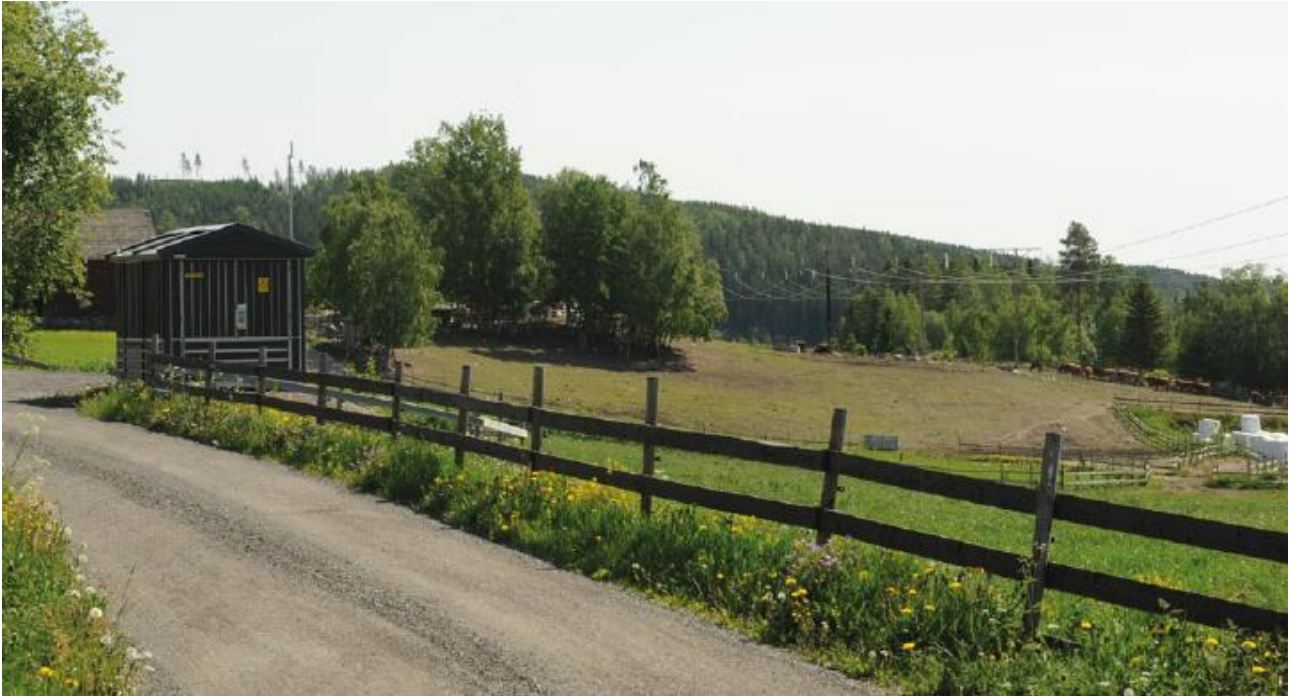
Figur 7-24 Dagens ledning ved Nedre Skjervum
