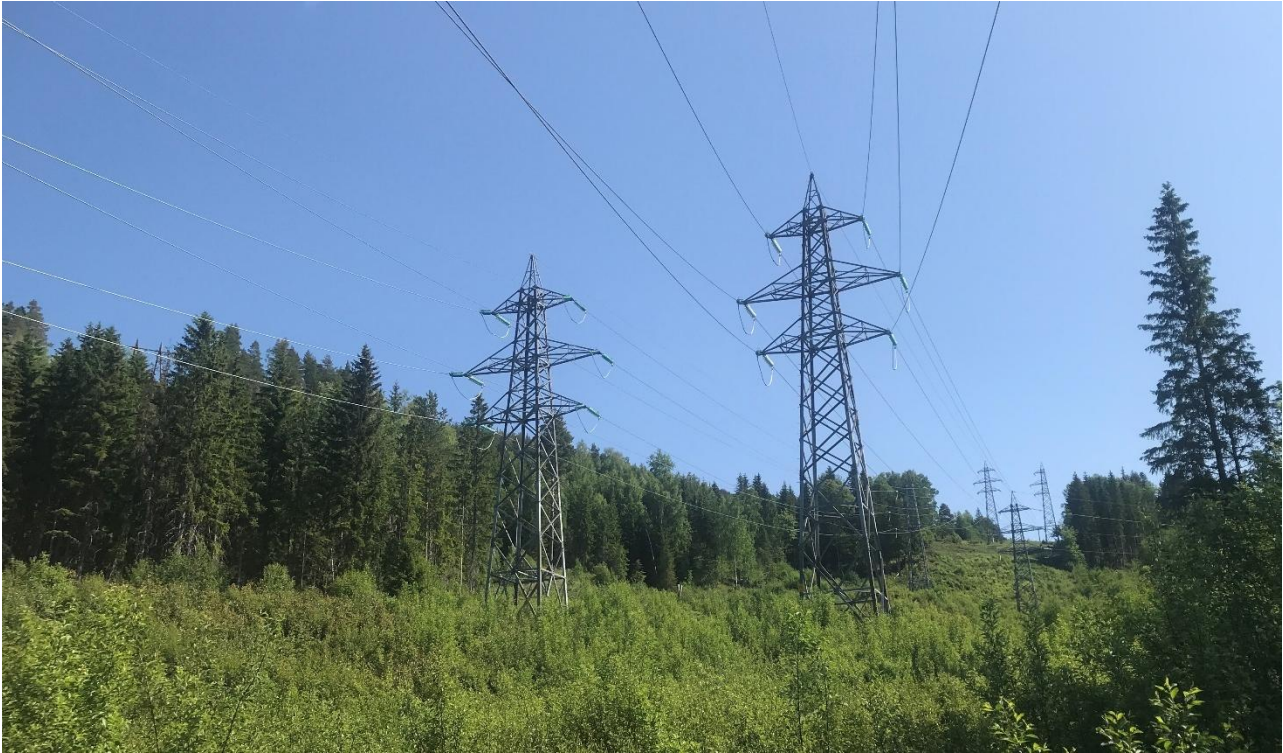
Figur 4-7: Dobbelkurs mastene ut fra Dokka transformatorstasjon. Masterekken til venstre skal rives.
