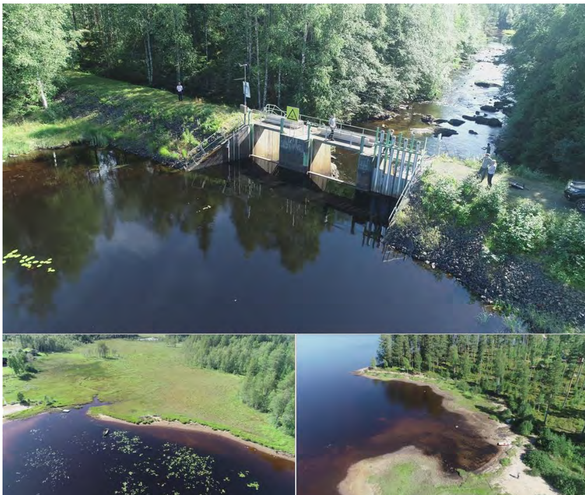
Figur 2-2: Bildene viser en vannstand i Mellom Røgden på ca. 330,05 moh. Bildene ble tatt på befaring den 22.08.22.
