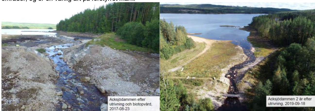
Figur 3-1: Bildene viser eksempel med damrivning fra Acksjönsdammen i Sverige. Det øverste bildet viser blottlagt bunnsubstrat etter nedtapping. Bildet til høyre viser dekning og fremvekst av vegetasjonen 2 år senere. Foto: Norconsult Sverige
