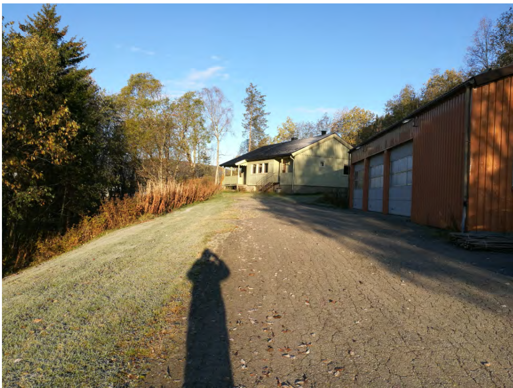
Figur 20: Eksisterende bygningsmasse på gnr. 99 bnr. 128
