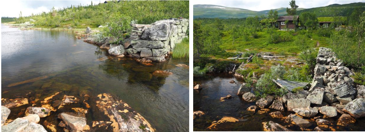
Figur 5: Venstre bilde: Dammens østre vederlag. Høyre bilde: Vestre vederlag og rester av gangbru.
