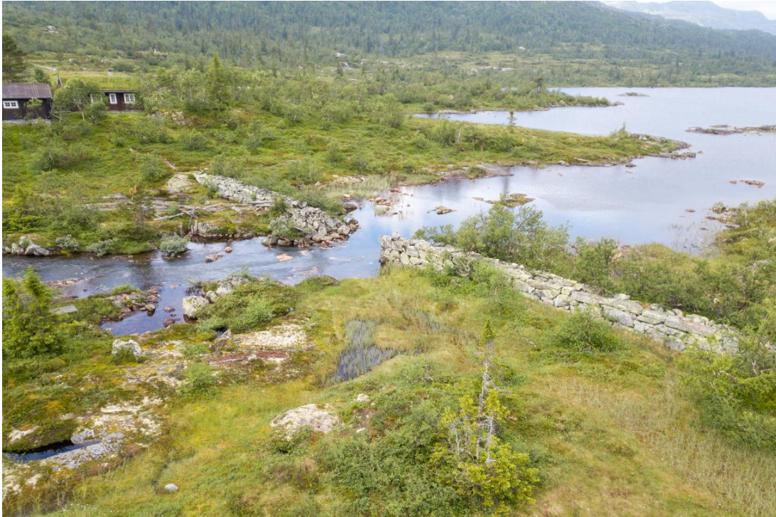
Figur 2: Dronefoto av eksisterende steindam, sett fra øst
