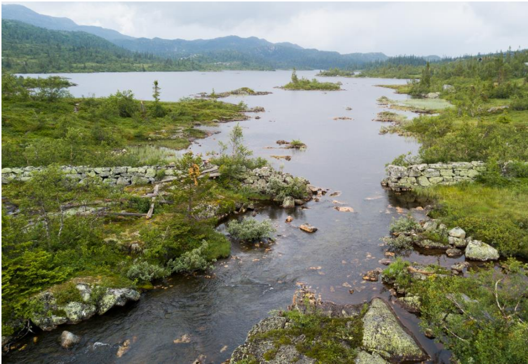
Figur 3: Dronefoto av eksisterende steindam, sett fra sør
