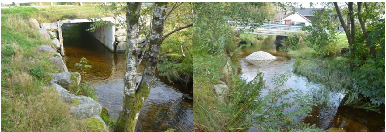
Byggverk nr. 320 og 321, gyttegrus ligger klar til utlegging i bekken
