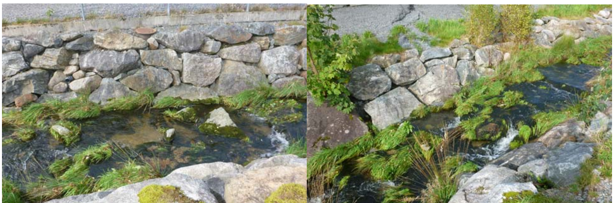
Vestlig elvebredd nedstrøms byggverk nr. 208
