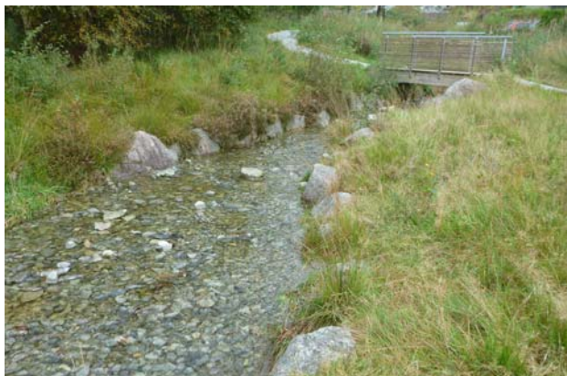
Innløp til massebassenget og byggverk nr. 213
