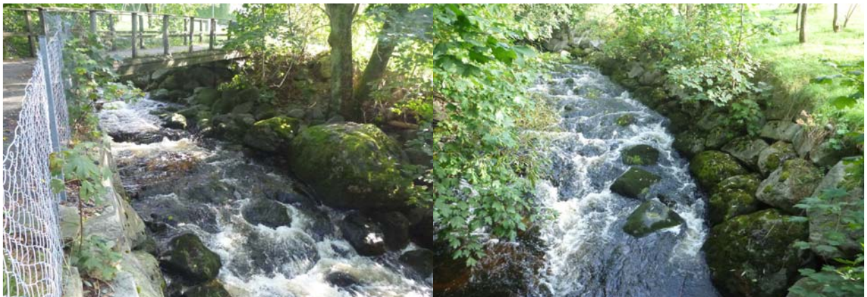
Byggverk nr. 302 og yttersving oppstrøms
