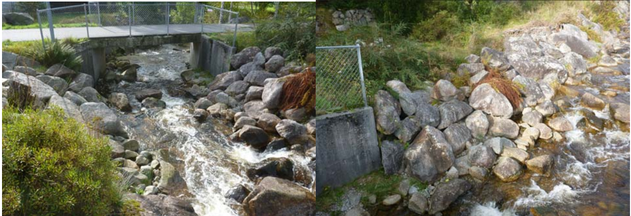
Byggverk nr. 322, sidesikring oppstrøms vestlig landkar
