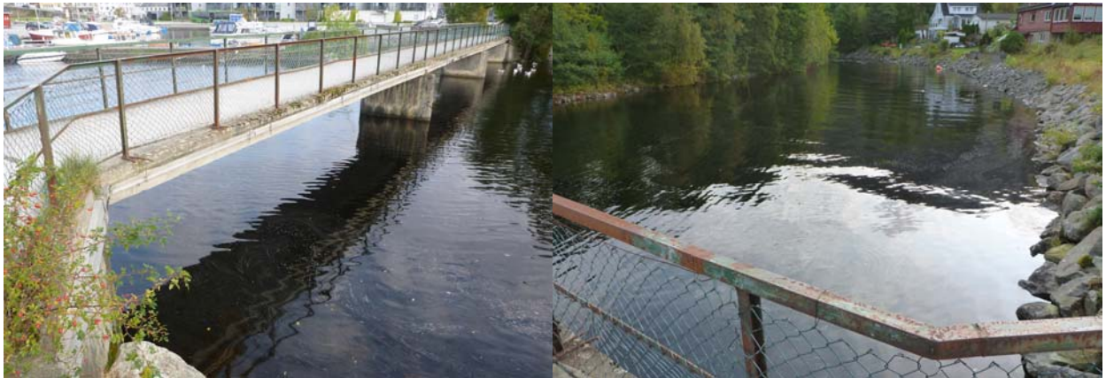
Byggverk nr. 80 ved utløpet i fjorden og oppstrøms strekning
