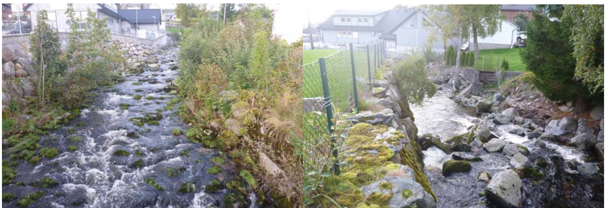
Oppstrøms byggverk nr. 304
