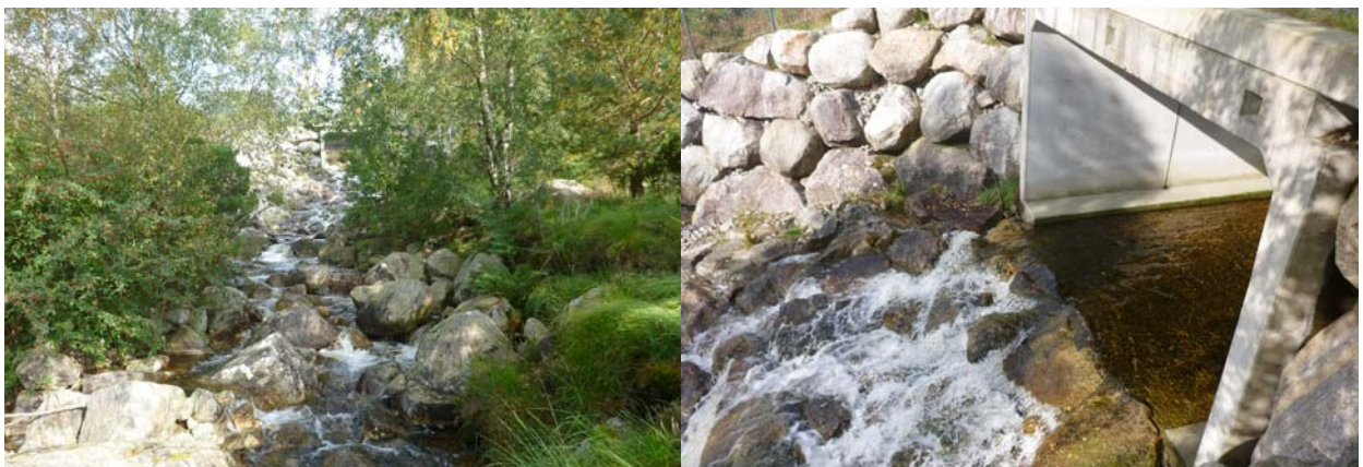
Nedstrøms byggverk nr. 324 sett mot kulverten; byggverk nr. 324, utløp og sidesikring
