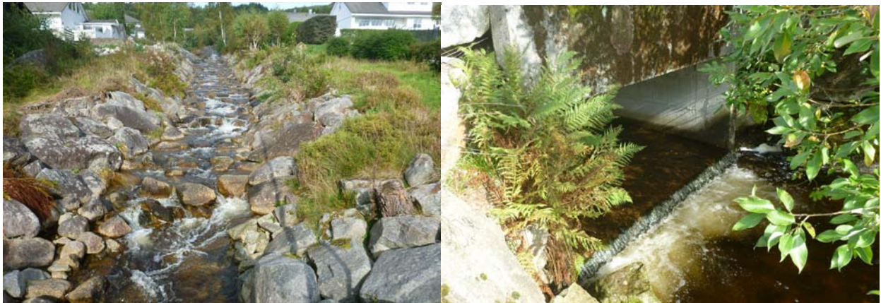
Oppstrøms byggverk nr. 322, sett fra brua
