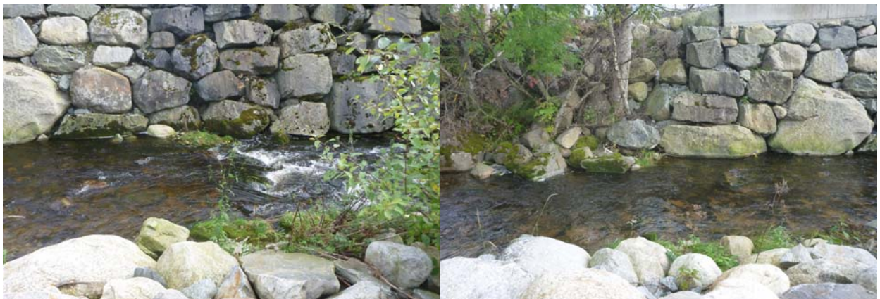
Sidesikring i yttersving
