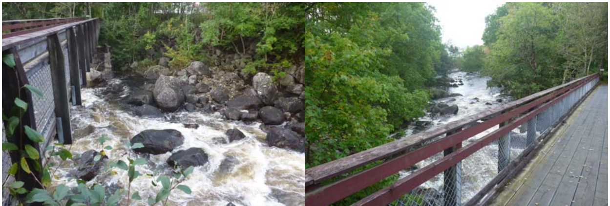
Byggverk nr. 81, sett mot nordlig landkar og i oppstrøms retning
