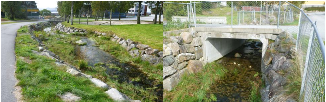
Nedstrøms byggverk nr. 208 og brua sett fra nedstrøms
