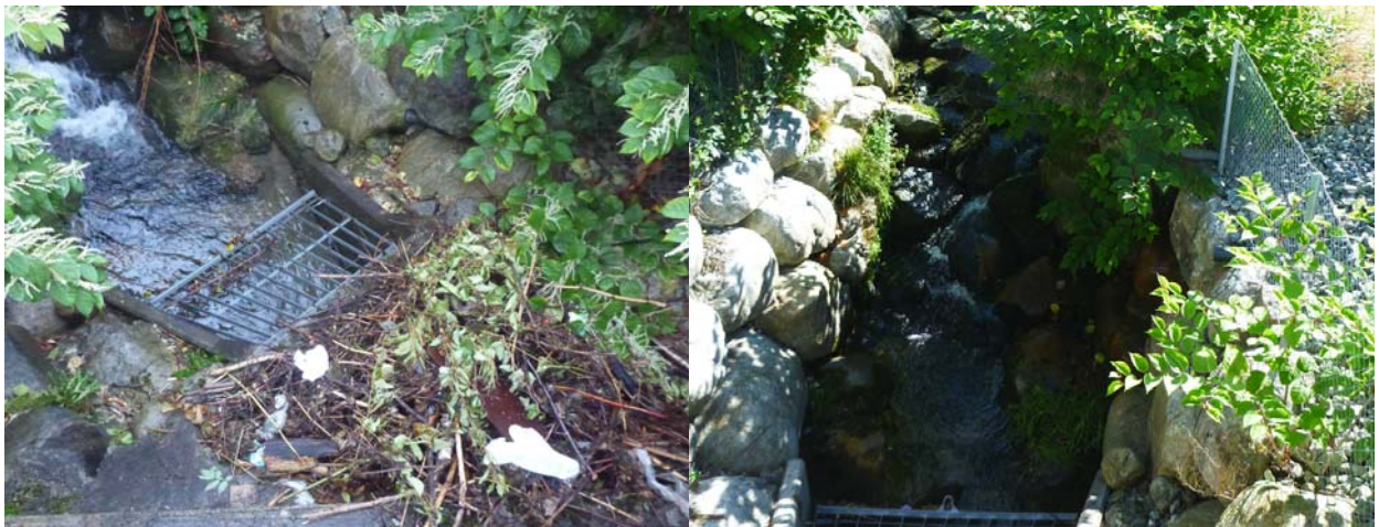
Inntak sidebekk v/Åvegen (høyre bilde fra juli 2021)
