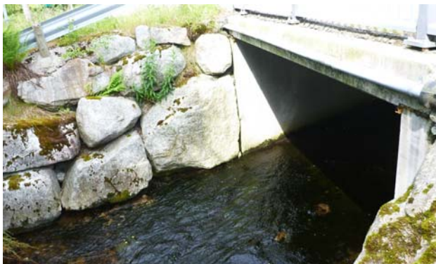
Byggverk nr. 313, innløp (bilde fra juli 2021)
