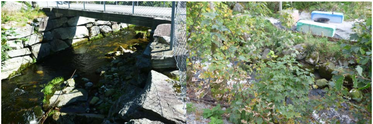
Byggverk nr. 305, sett fra nedstrøms, og sørlig breidd oppstrøms brua
