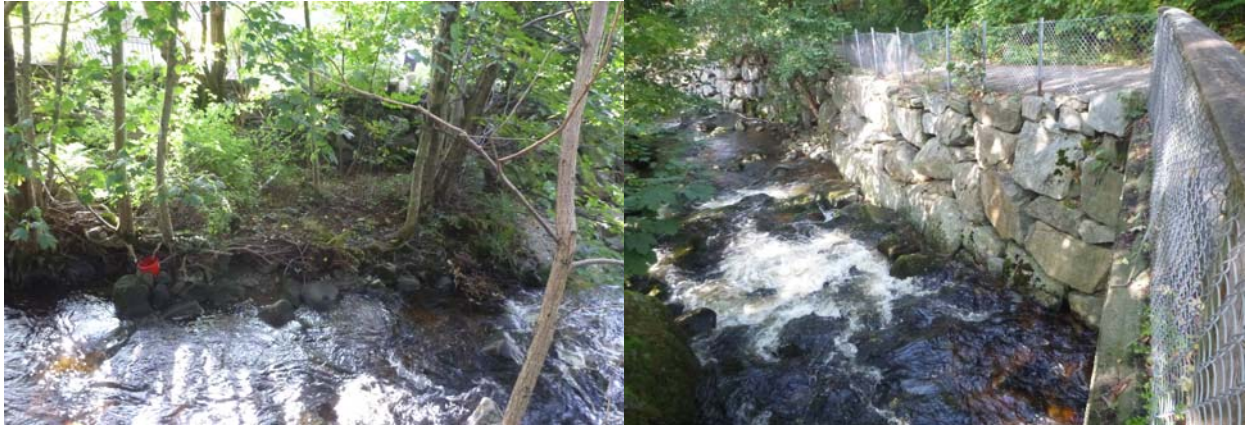
Nedstrøms byggverk nr. 302
