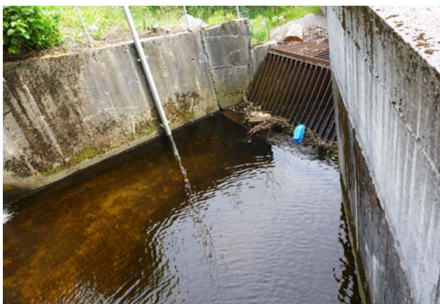
Inntak til Sørskårbekken i Gneisvegen (bilde fra juli 2021)
