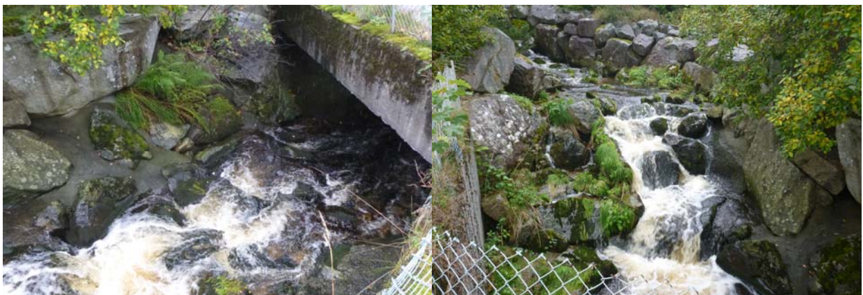
Byggverk nr. 309, innløp og oppstrøms
