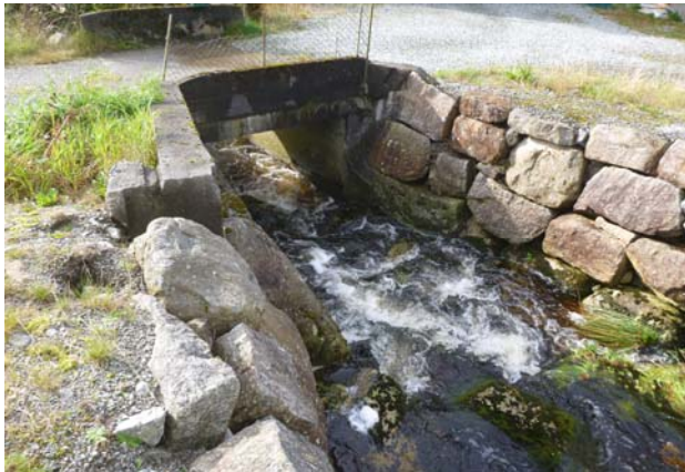
Byggverk nr. 334, sett fra oppstrøms
