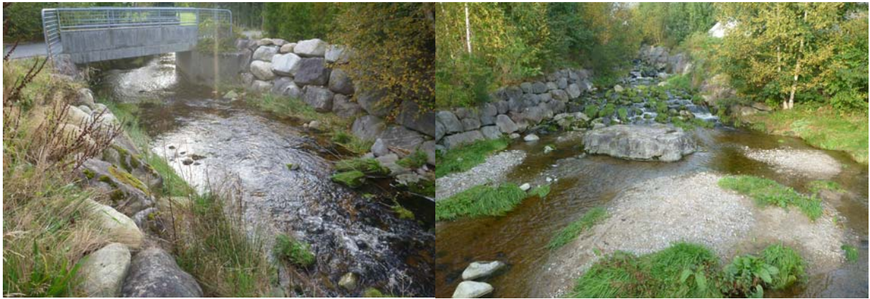
Byggverk nr. 307 ved samløpet med Fiskåna og massebasseng rett oppstrøms
