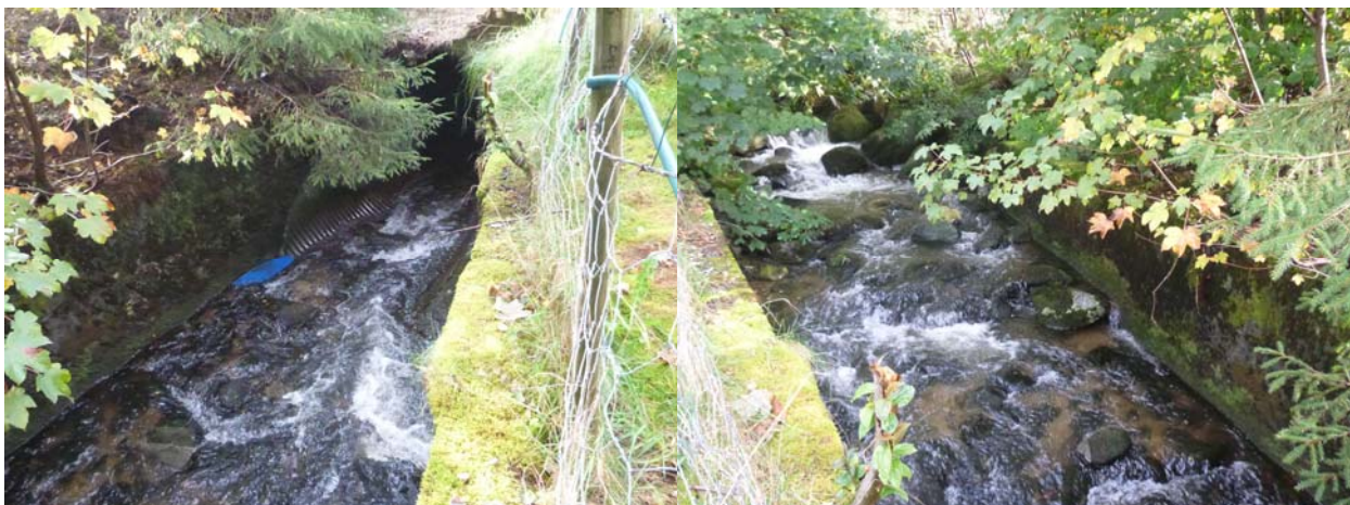
Byggverk nr. 204, innløp og oppstrøms strekning
