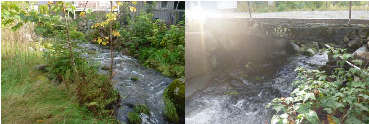
Nedstrøms byggverk nr. 203 og brua sett fra oppstrøms
