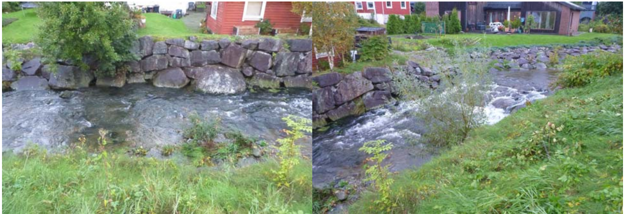
Fiskåna oppstrøms Nedre Barkvedvegen langs Østvollvegen
