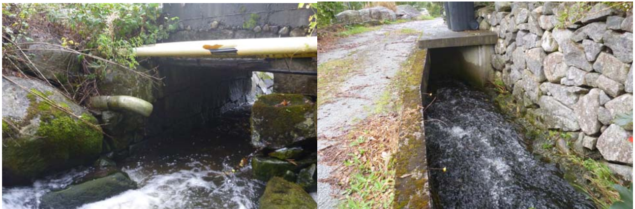
Innløp til byggverk nr. 201 og 202
