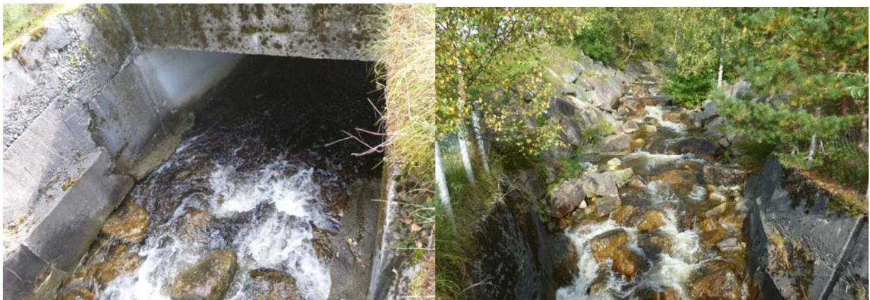
Byggverk nr. 323, innløp og oppstrøms
