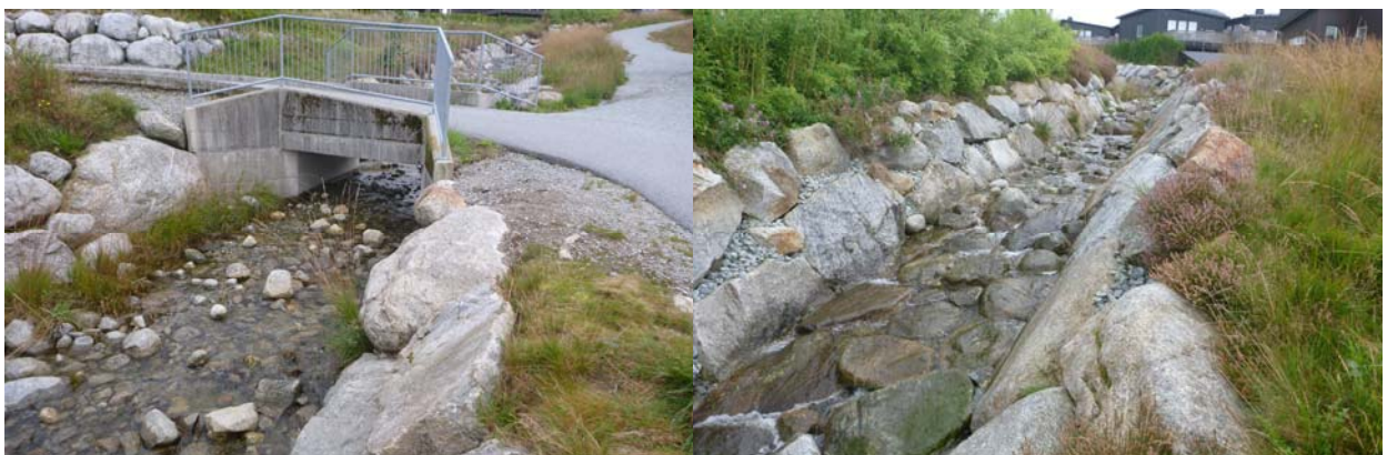
Byggverk nr. 211, sett fra nedstrøms
