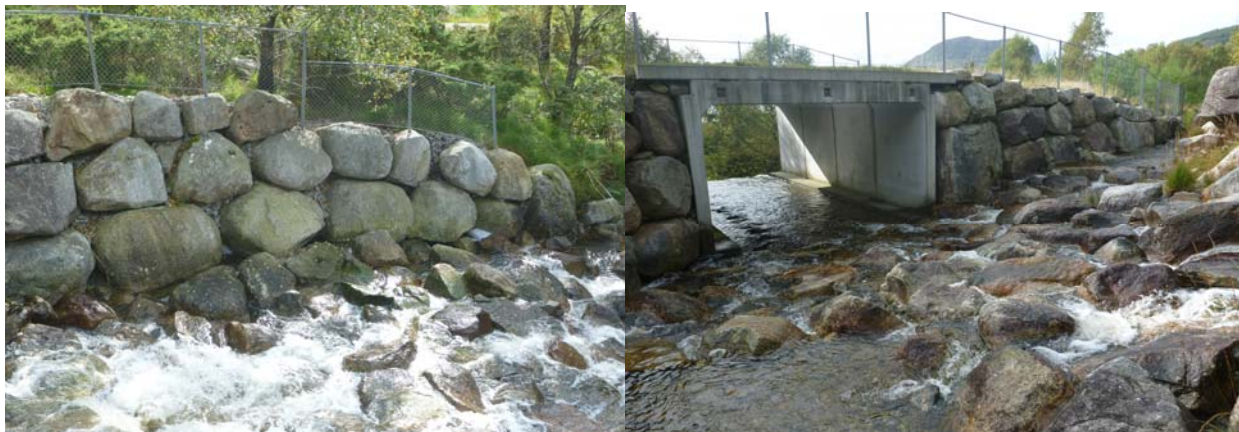
byggverk nr. 324, sidesikring ved utløpet og sett fra oppstrøms
