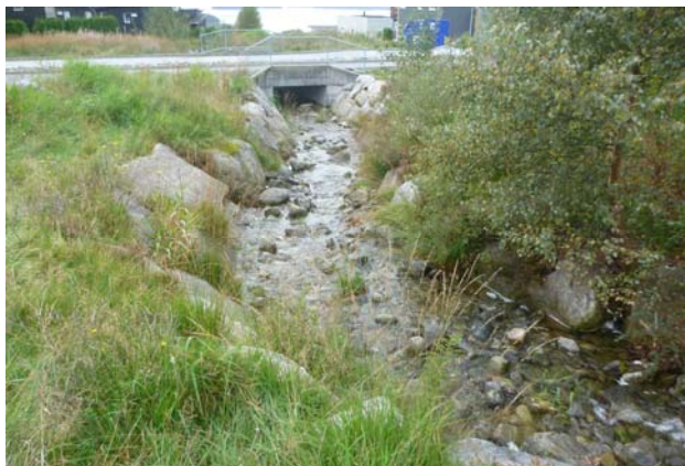
Byggverk nr. 212, sett fra oppstrøms
