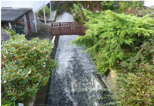
Vannrenne sett nedover fra byggverk nr. 336
