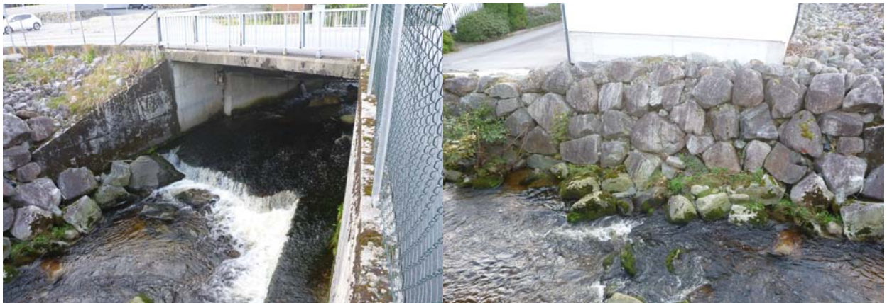
Byggverk nr. 304, utløp og vestlig bredd nedstrøms utløpet
