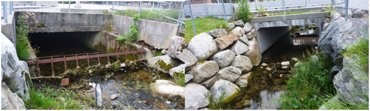
Byggverk nr. 205, innløp
