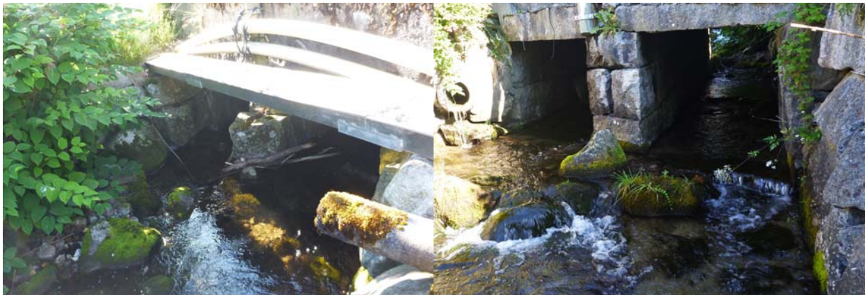
Byggverk nr. 100, utløp og innløp (bilder fra juli 2021)
