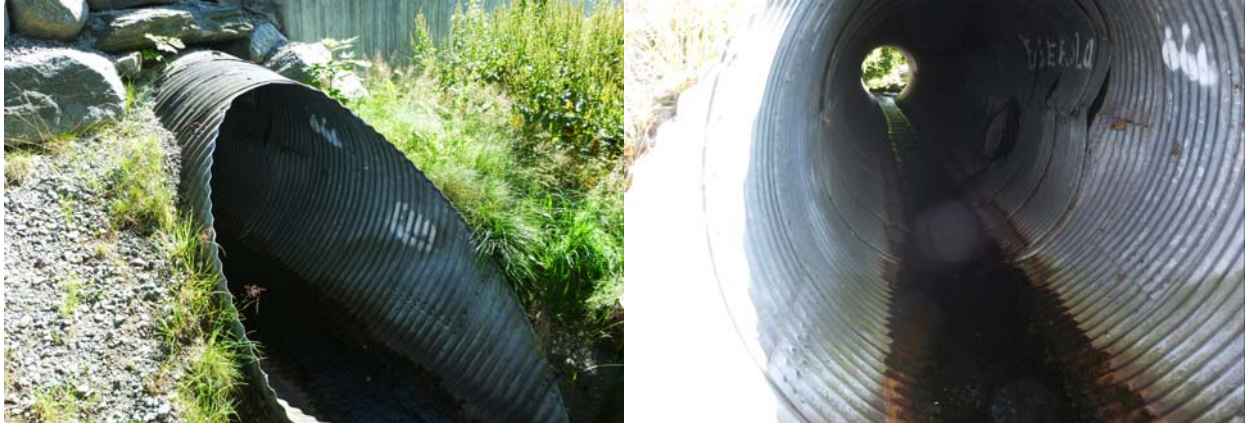
Byggverk nr. 351, utløp og sett i oppstrøms retning (bilder fra juli 2021)
