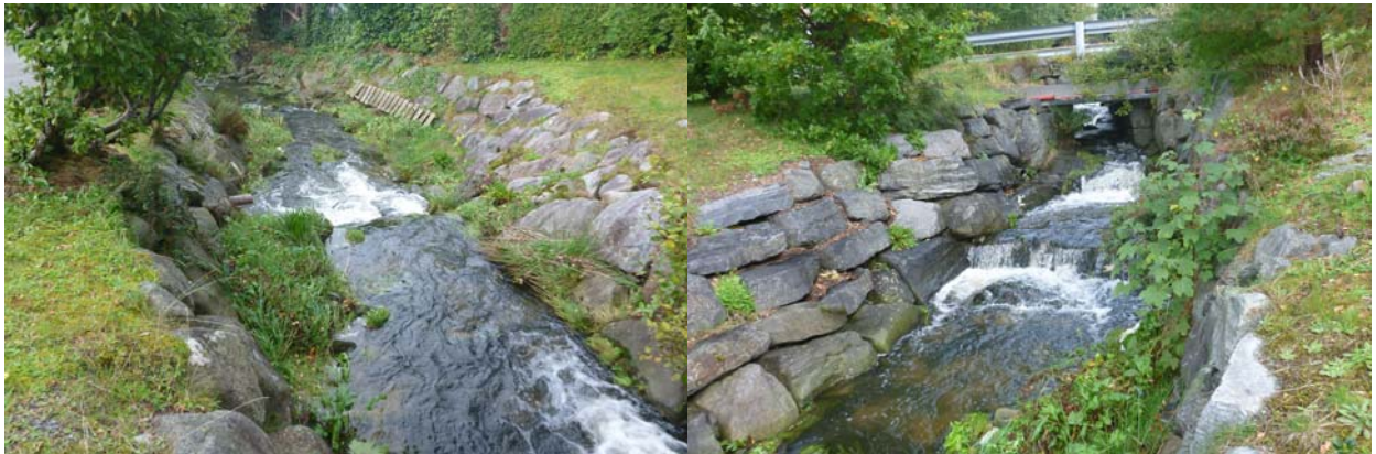
Nedstrøms Nedre Barkvedvegen, byggverk nr. 201
