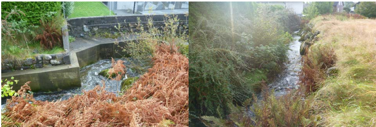
Mellom byggverk nr. 203 og Ryfylkevegen
