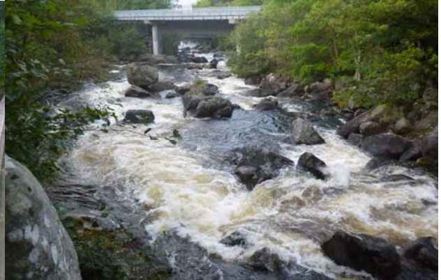
Byggverk nr. 82/83 sett fra oppstrøms
