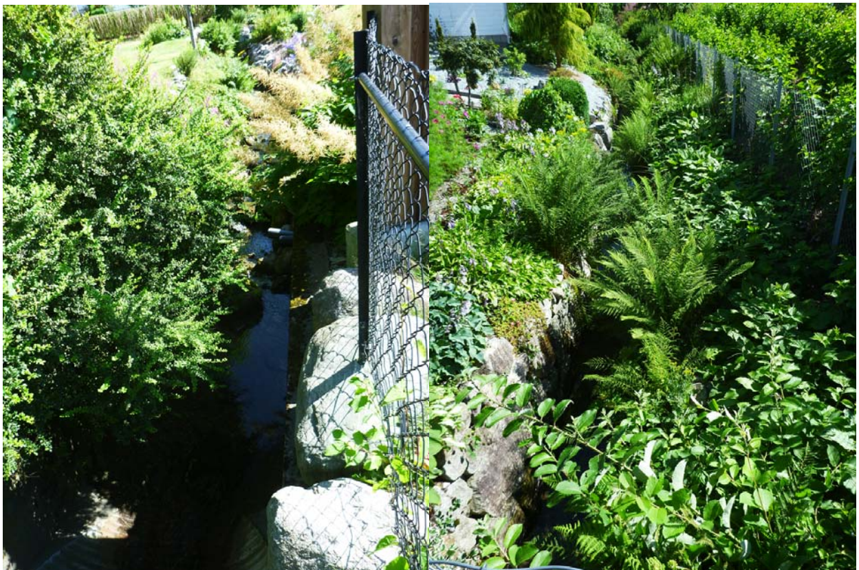
Innløpsstrekninger til byggverk nr. 351 og 352 (bilder fra juli 2021)
