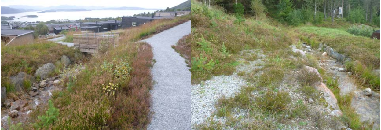
Byggverk nr. 217, sett fra oppstrøms
