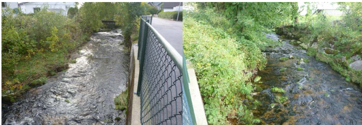
Oppstrøms byggverk nr. 306
