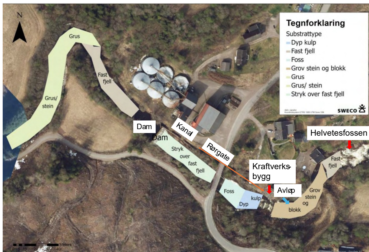
Bilde 1 Oversiktsbilde hentet fra Akvatisk rapport utarbeidet av Sweco. Bunnsbunnsstrat i elva er markert og viser fast fjell fra inntaksdam og ned til kraftverksbygning.
