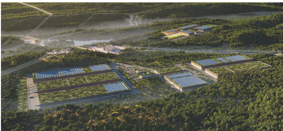
Figur 13 Illustrasjon av Bøylestad Energipark fra Bøylestad Energipark sin nettside ( https://boylestad.no/ )
