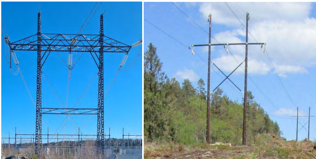
Figur 26 Eksempel på duplex-ledning bygget som fagverksmast i stål (til venstre) og en simplex-ledning bygget med komposittmast (til høyre)
