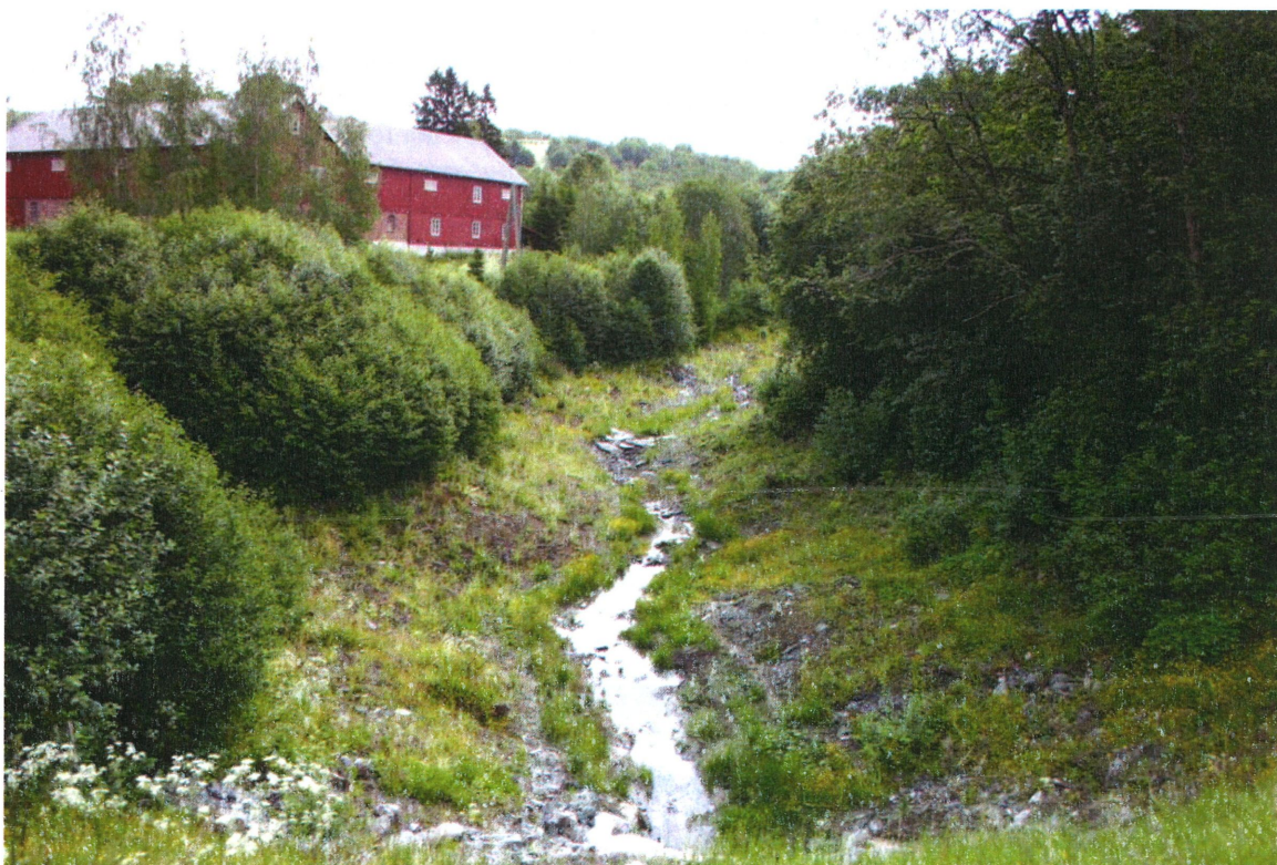
Figur 4 Erosjonssikring med miljøtiltak. Vegetasjonen kommer raskt tilbake.
