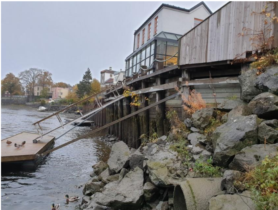
Nedstrøms ende for planlegging ny sikring, inn mot privat sikring av trepeler
