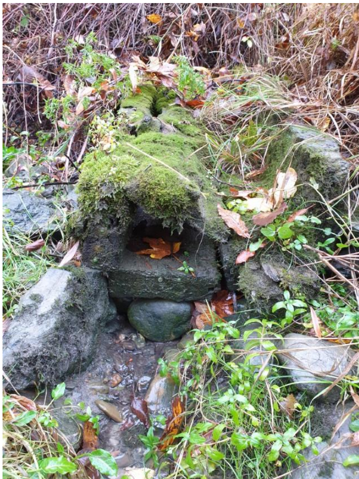
Trerør i skråningen rett overfor trappa i Gåsaparken på motsatt side av Nidelva. Nordøst for Kjøpmannsgata 1.
