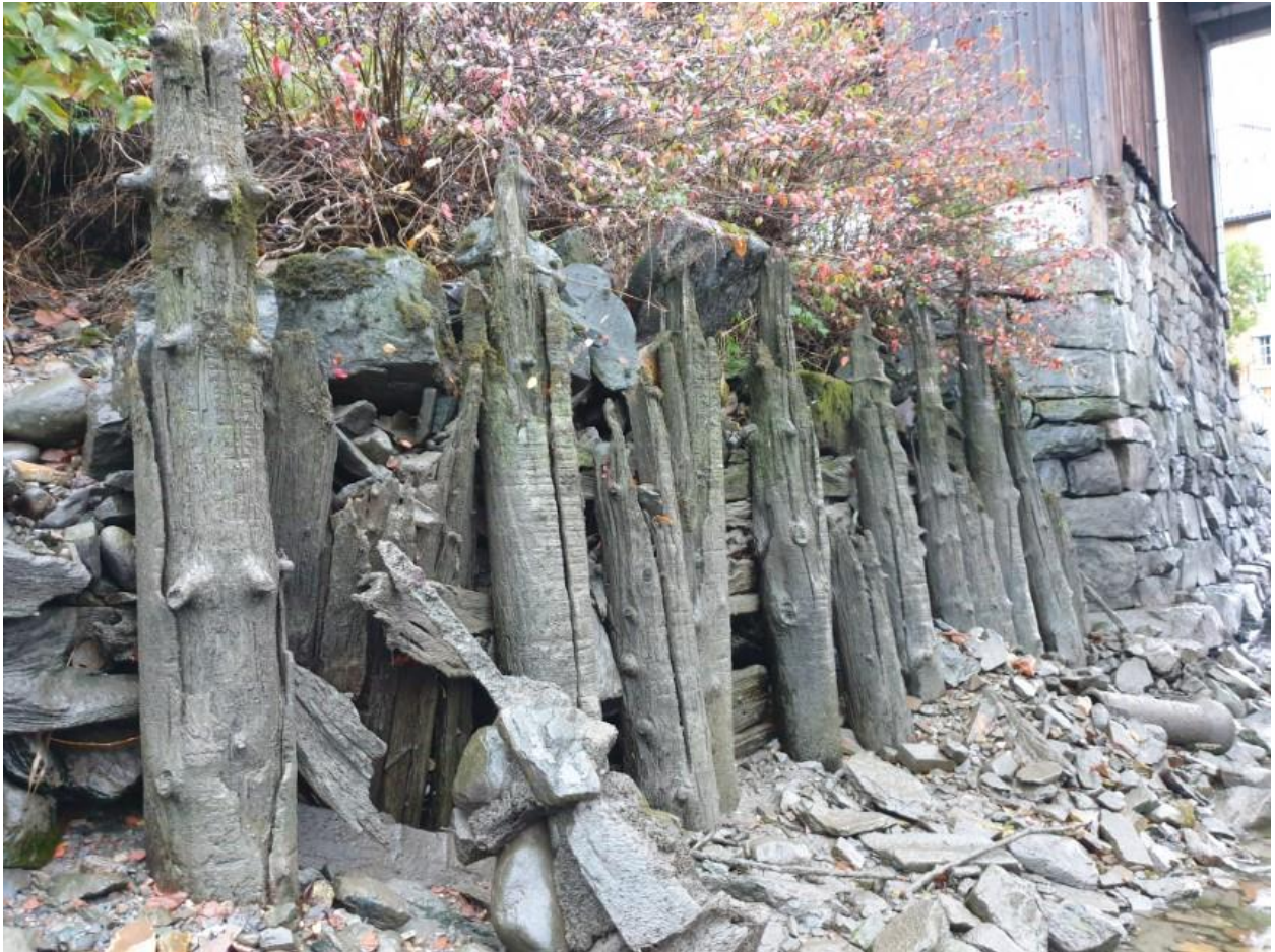
Pelerekke inn mot brofundamentet.
