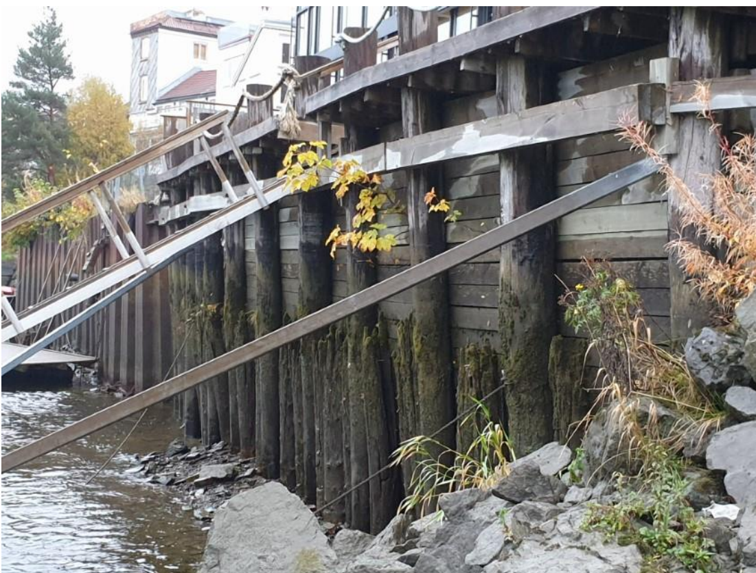
Nedstrøms ende for planlegging ny sikring, inn mot privat sikring av trepeler
