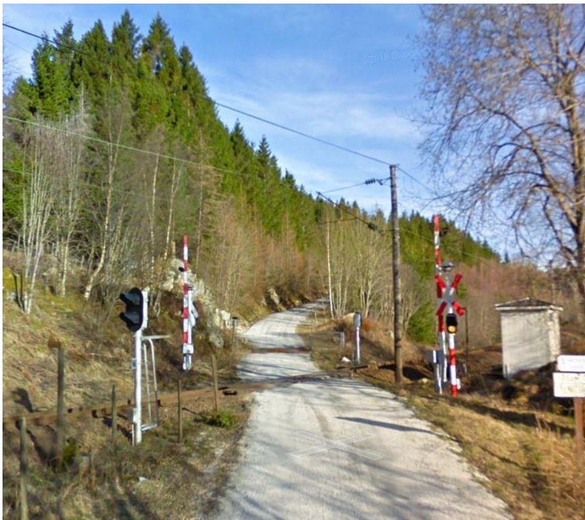
Figur 2-24 Kryssing av jernbanelinje før Kjelland stasjon
