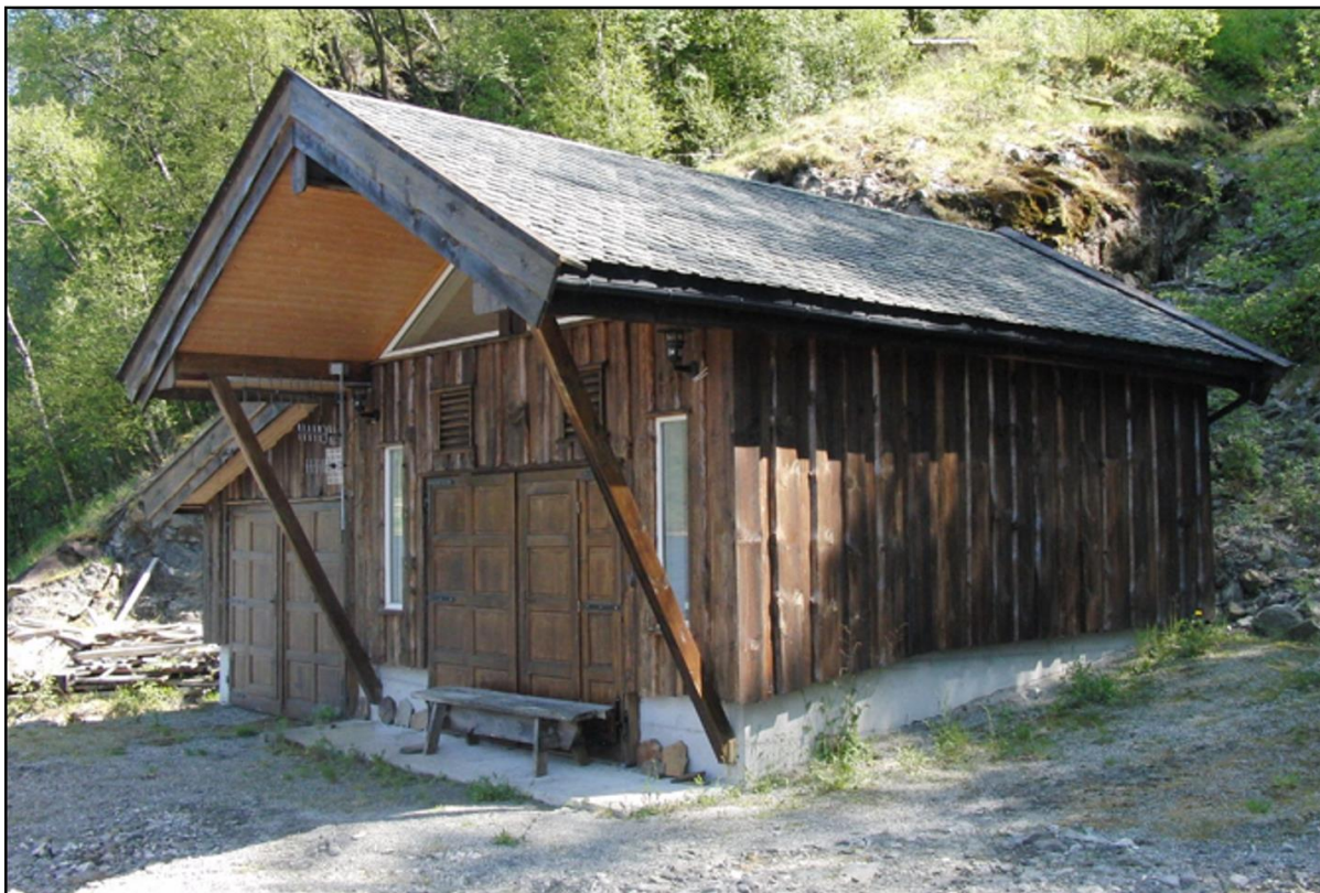
Figur 4. Bjørgjo kraftstasjon på kote 2,5 nær Etnefjorden. Foto: PeltonMan/Wikipedia Commons.
