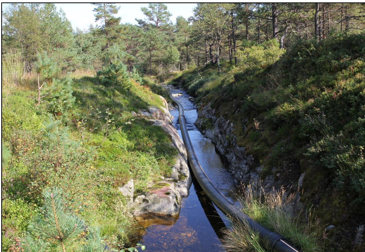
Figur 5. Bekken som renn nordover frå Krokavatnet og Langavatnet er avleidd via ein kort kanal inn til Myrkavatnet. Overføringskanalen er gammal, men blei utbetra då Bjørgjo kraftverk blei bygt i 2009.
