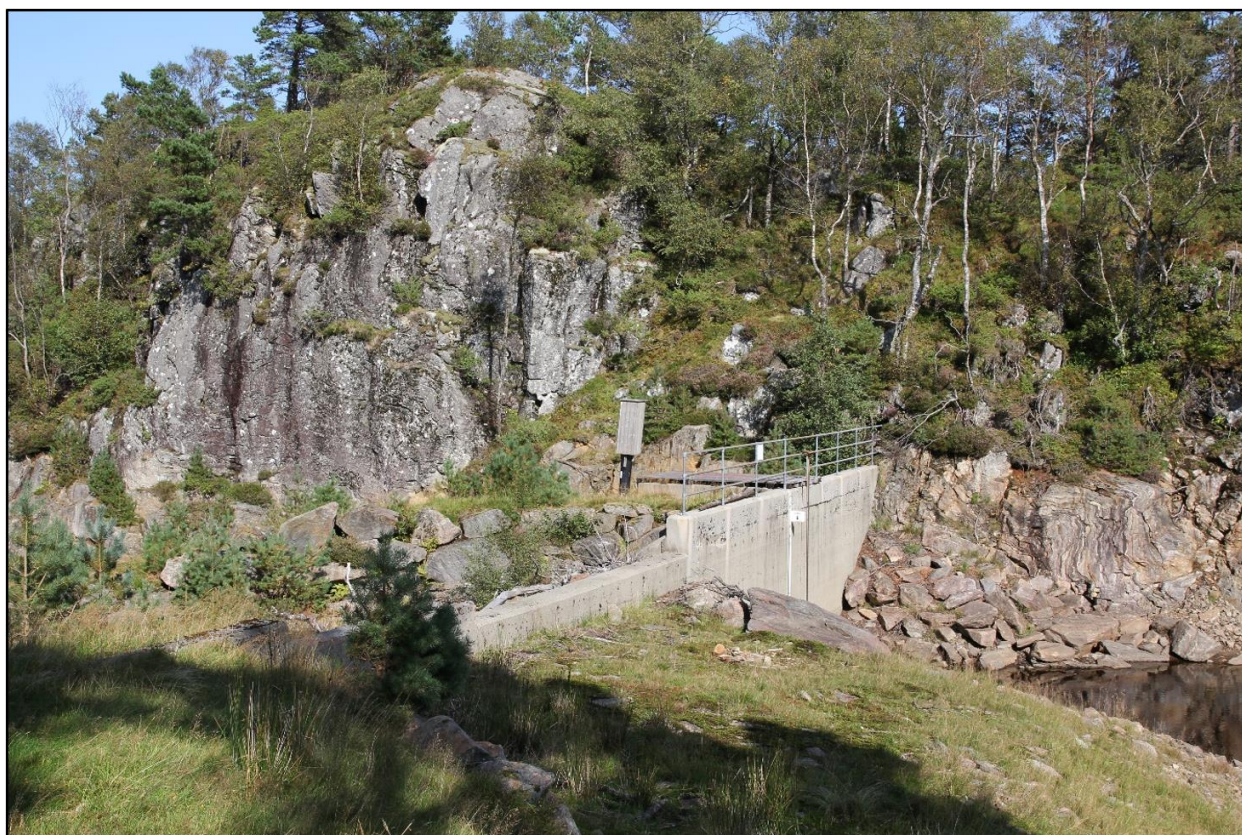
Figur 3. Dammen i Myrkavatnet fotografert 1. september 2023.
