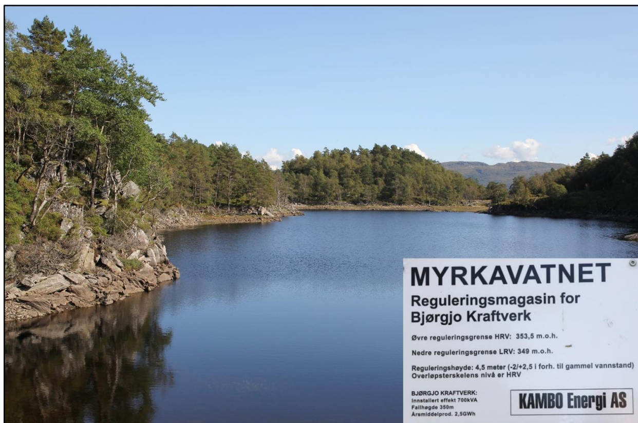
Figur 2. Kraftverksinntaket ligg i Myrkavatnet og har 4,5 m reguleringshøgde (353,5-349,0 moh).
