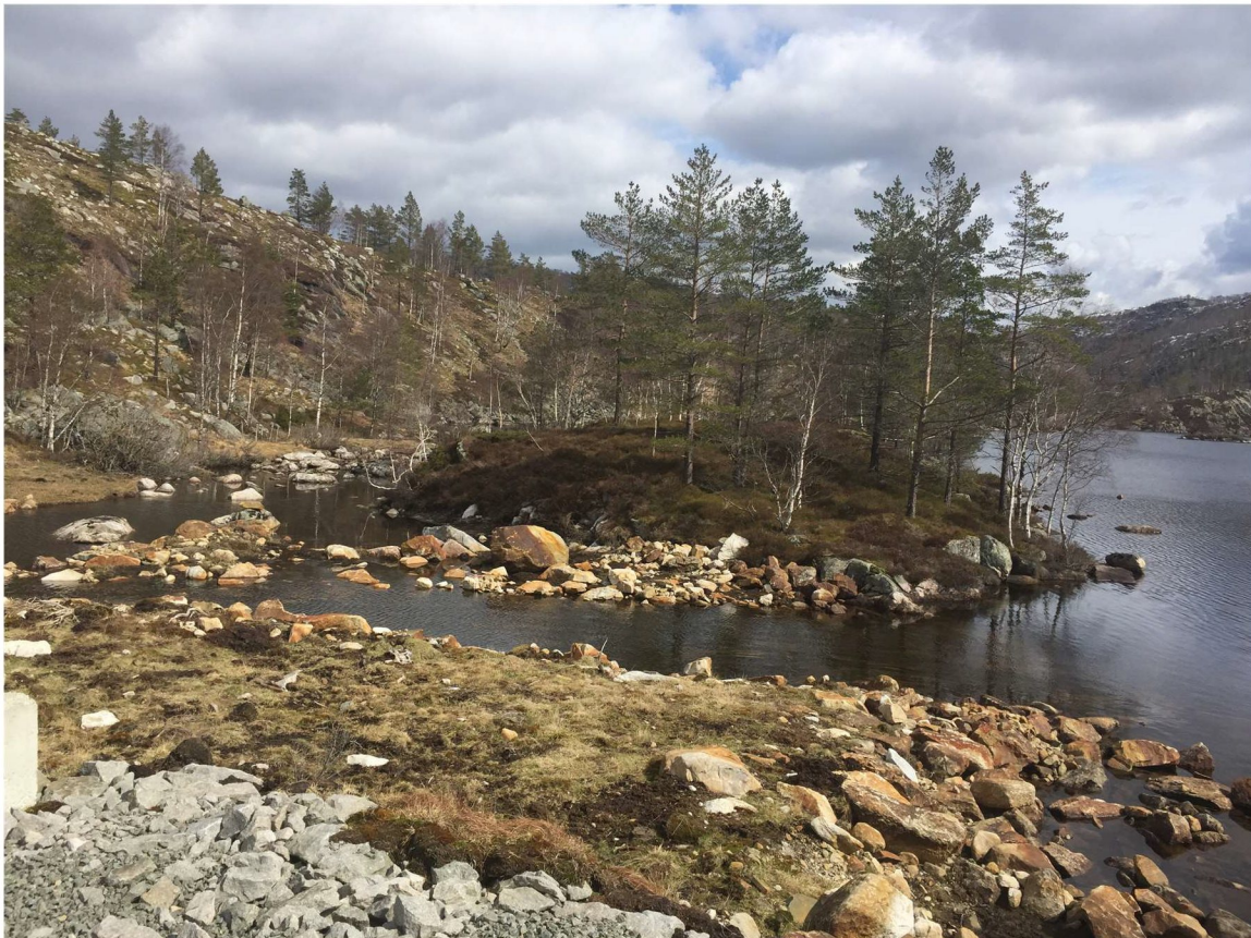
Ljosvatn – innløp mot dam.
