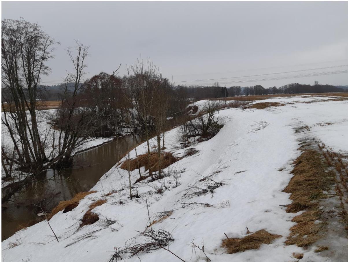
Område 3. Utsikt retning nordover, sett fra Østre Åmodt bru. Borgebekken til venstre [bilde tatt 01.03.24].
