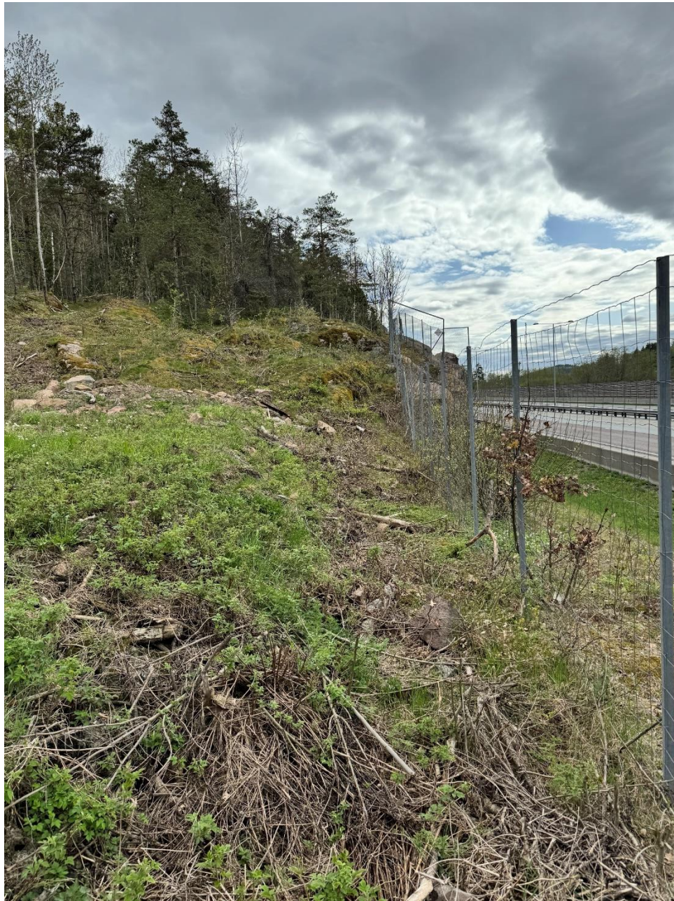
Område 4. Berg i dagen på sørvestsiden av stasjonstomta, ned mot E18 [bilde tatt 06.05.24].
