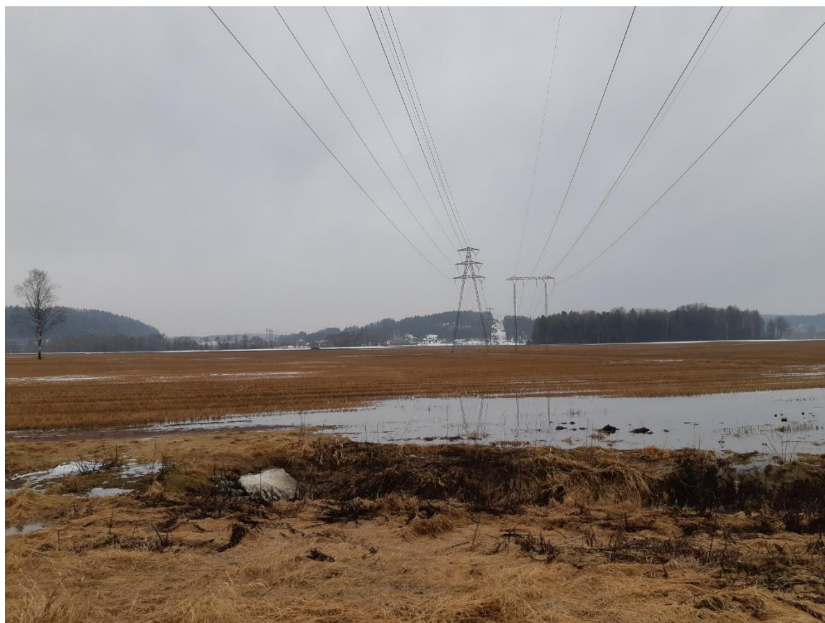
Område 1. Utsikt retning sørvestover mot mastekrysset ved Hesby, sett fra Kjerringhøvet [bilde tatt 01.03.24].
