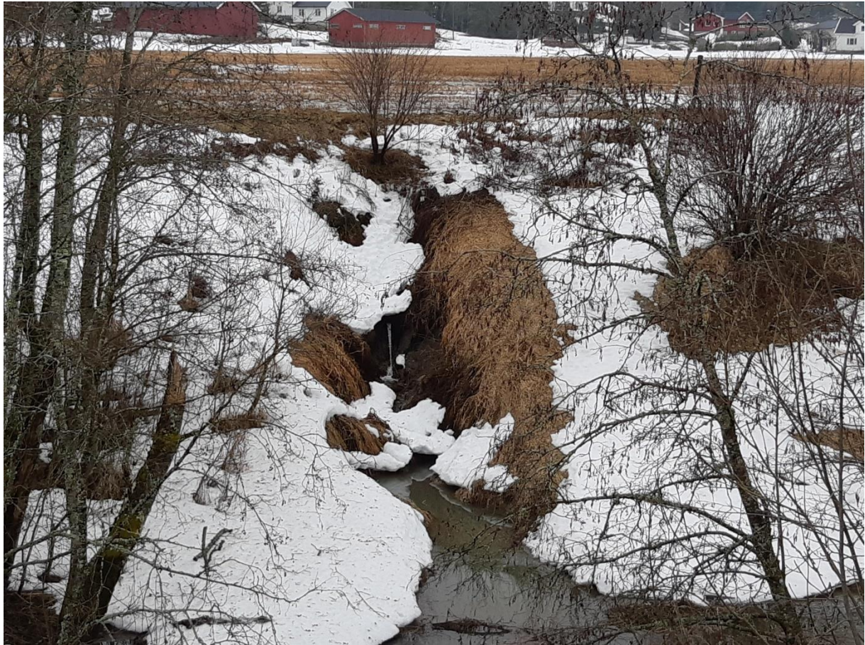
Område 3. Erosjon ved Borgebekken [bilde tatt 01.03.24].
