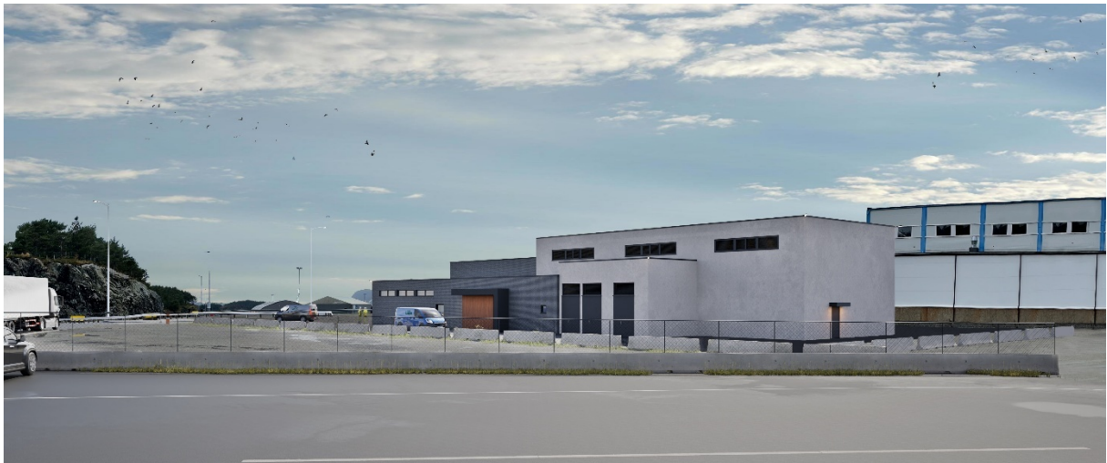
Figur 6: Utforming av Botnaneset transformatorstasjon sett fra sørøst.
