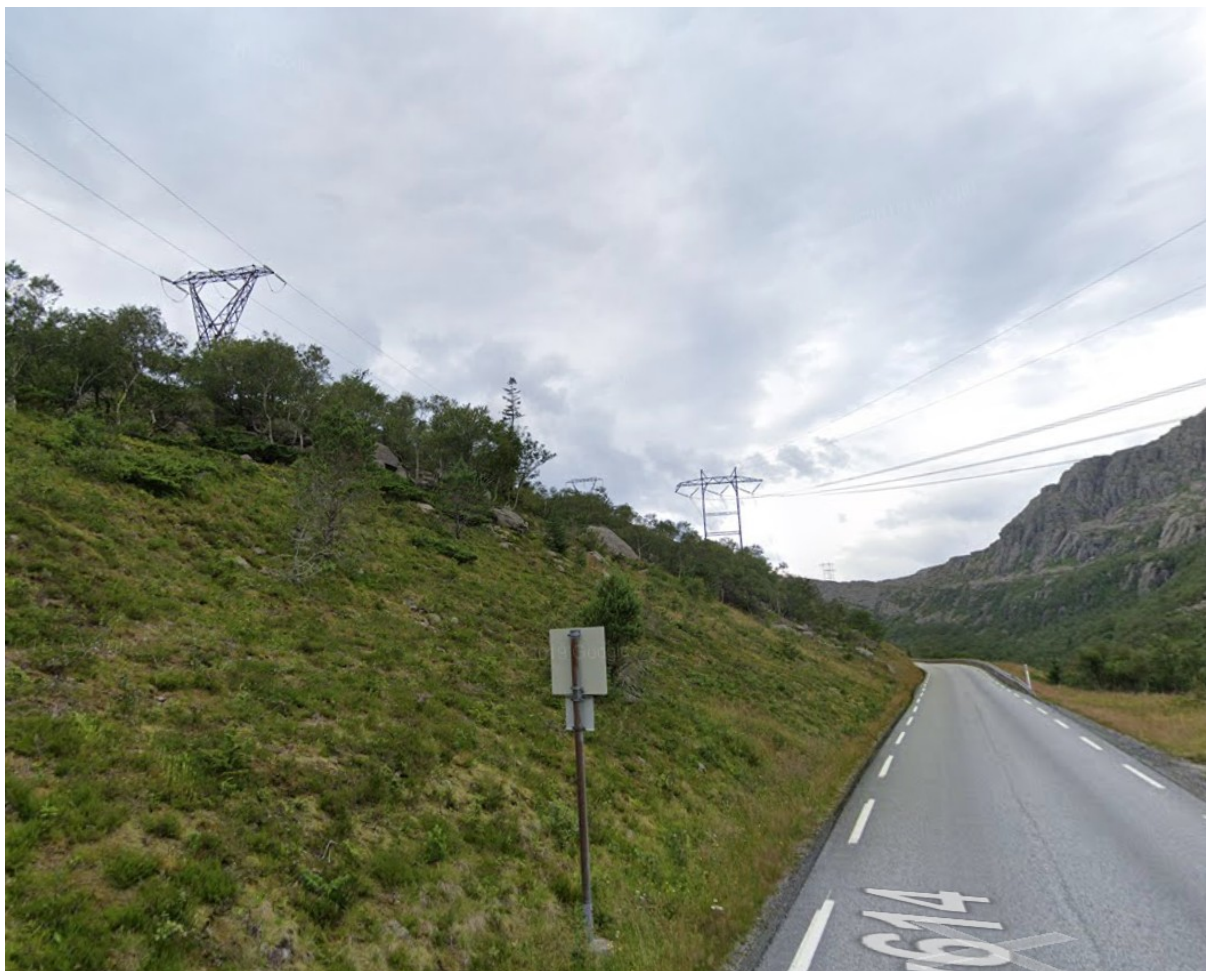
Figur 11: Ned Grytadalen går det en 132 kV ledning og en 420 kV ledning. Ny 132 kV vil parallellføres med eksisterende 132 kV ledning.
