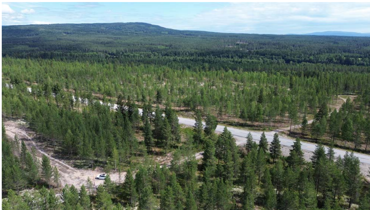
Figur 7-1: Oversiktsbilde fra vest mot øst. Bildet er tatt fra/over Hovdmoen skytteranlegg, og viser bl.a. tidligere etablerte skogsbilveger. Foto: Vindr.
