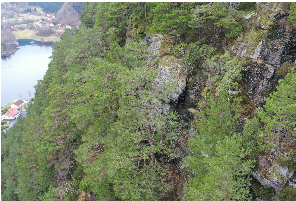
Figur 96: Ei nesten avløyst blokk i øvre del av fjellsida. Blokka har ikkje støtte i grunn i underkant og eit sprekkesett som utviklar seg i bakkant langs fjelloverflata. Infopunkt 7.
