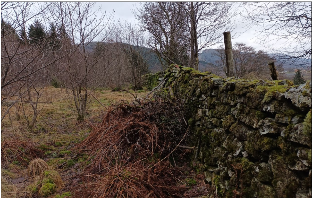
Figur 125: Det er ein steinmur langs foten av midtre del av fjellsida, som er om lag 1,5 meter høg. Markerer avgrensinga mellom innmark og utmark. Steinmuren er vurdert til å bremse skred, og er markert som sikringstiltak i registreringskartet (kap. 17.4).
