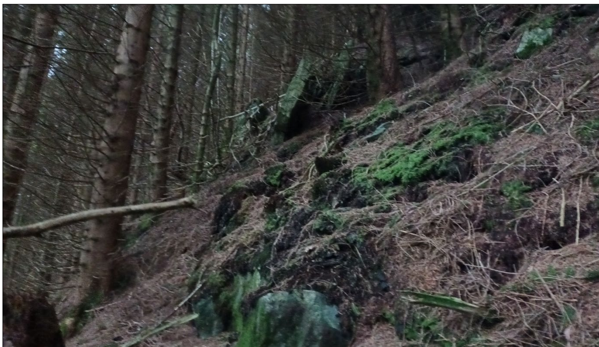
Figur 54: Gneisen i fjellpartia i nedre del av fjellsida har høg oppsprekking og det ligg relativt ferskt steinsprangmateriale (<100 år) kort avstand frå desse partia. Infopunkt 5.
