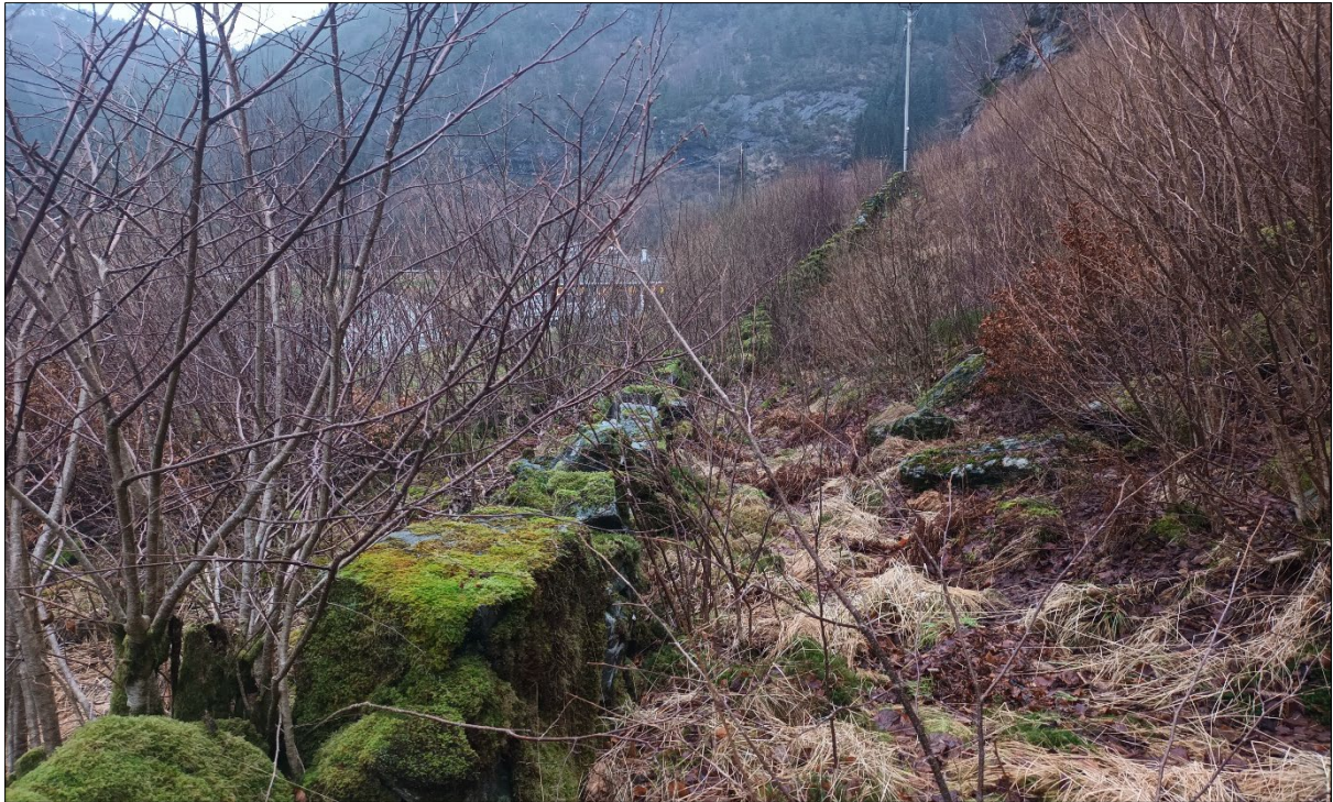
Figur 138: Det er ein steinmur som føl foten av fjellsida og endar opp i fangvollen ved infopunkt 9. Lokalkjende informerer om at muren hovudsakleg er sett opp for å avgrense innmarka, men muren vil ha ein reduserande effekt på små steinsprang eller jordskred.
