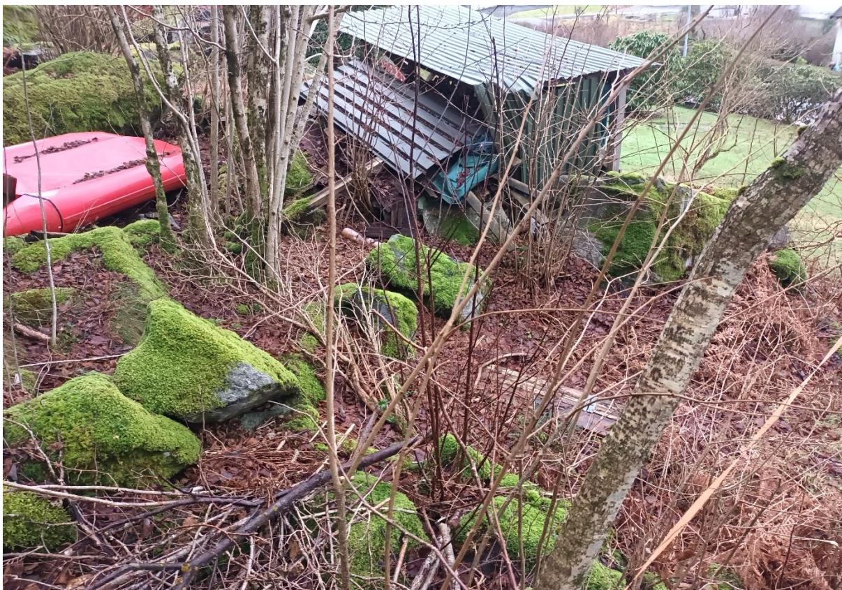
Figur 95: Steinsprangmateriale/ur tett på bustadområde. Det er antatt at delar av ura er fjerna for utbygging. Infopunkt 6.
