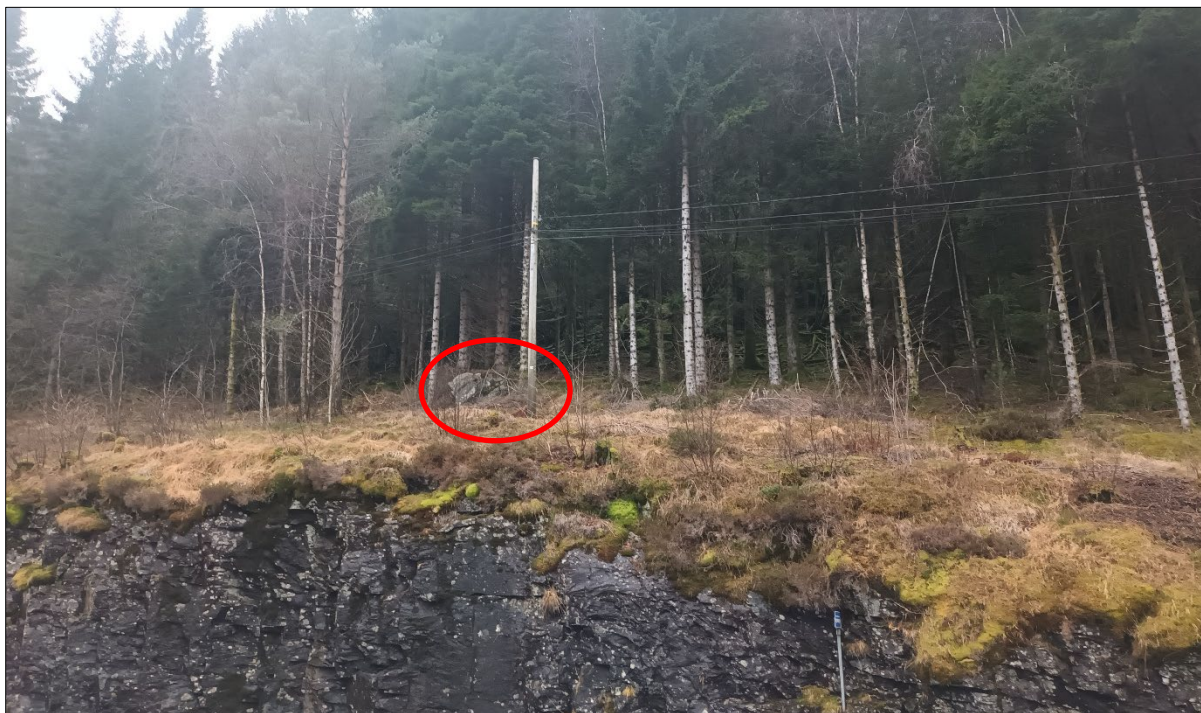
Figur 99: Ytste observerte steinsprangblokk ligg om lag 10 meter vest for skjeringa langs Bøfjordvegen. Markert med raudt omriss.
