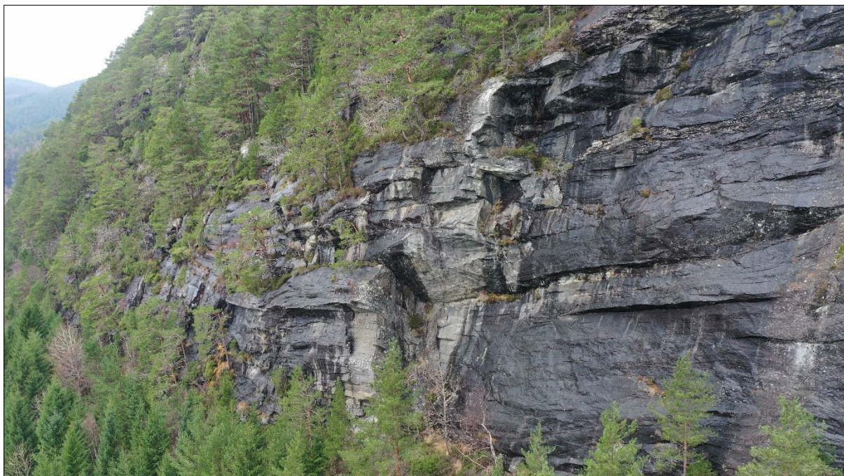
Figur 20: Sprekkeplan langs fjelloverflata i lag med orienteringa til foliasjonsplana har ført til at utrasingar har skjedd nedanfrå og opp, noko som har ført til utsikkande parti og overheng i øvre del av fjellsida.
