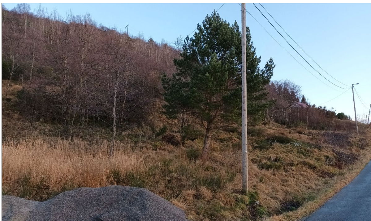
Figur 144: Skråninga nord for Lekvavegen er slak, og har eit tynt lausmassedekke av forvittringsmateriale og organisk materiale.
