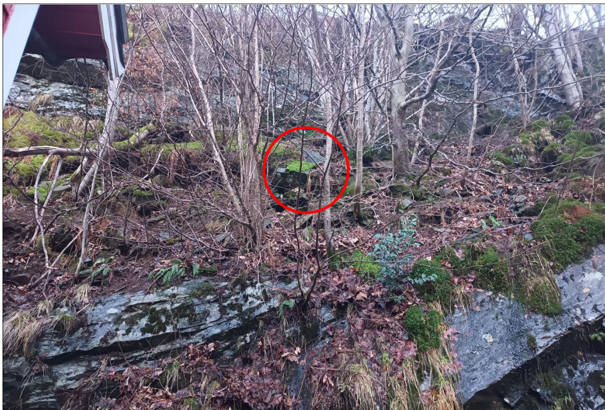
Figur 74: Fjellskrent ved infopunkt 13. Tilgjengelege flyfoto viser at det er gjort endringar i samband med utbygging i vestleg del av fjellskrenten, men at det ikkje har vore store inngrep. Fjellskrenten er difor vurdert som naturleg terreng. Det vart observert små steinsprangblokker i hyllepartiet i fjellskrenten, antatt å vere yngre enn 100 år (markert med raudt omriss).
