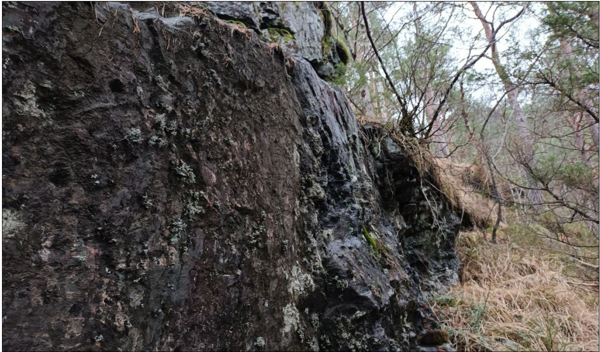
Figur 108: Forutan om den tilnærma avløyste blokka i austleg del av hammarpartiet er fjellet vurdert som massivt. Det er spor i berggrunnen etter forvitring, men ingen vesentleg sprekkdanning.
