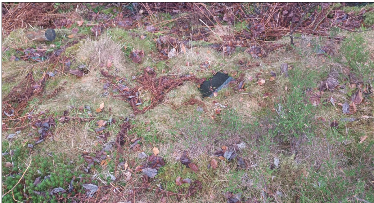
Figur 75: Bilete er tatt frå toppen av fangvollen ned mot sida som vender mot fjellet. Det er ei relativt fersk steinsprangblokk (antatt yngre enn 30 år) som har hatt nok energi til å grave seg eit stykke inn i vollen. Det vart observert fleire relativt ferske steinsprangblokker langs vollen. Infopunkt 9.
