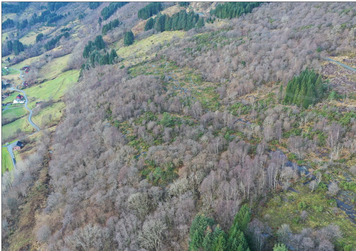
Figur 126: Terrenget i nedre del av påverknadsområdet er slakt, der fleire parti har helling under 10°. Småmyrene dannar eit slakt parti med hovudsakleg fast fjell, der erosjon av eventuelle skred vil vere kraftig redusert. Infopunkt 4.
