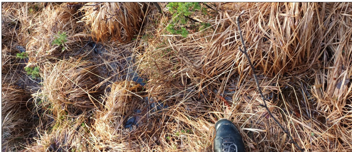
Figur 88: Under synfaringa vart det observert ein liten dreneringsveg i øvre del av påverknadsområdet. Vatnet renn hovudsakleg som overvatn over lausmassane og vegetasjonen, og det er ingen vesentlege erosjonsspor.
