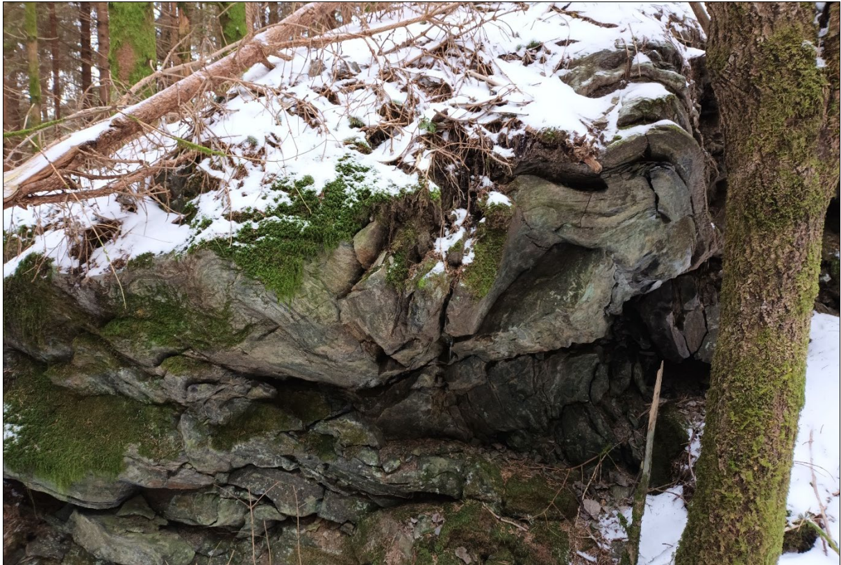
Figur 122: Fjellblotting med kraftig lokal falding. Faldeprosesser i berggrunnen har ført til at sprekkesetta stadvis i fjellet er kaotiske, og det er lokale oppknusingssoner i fjellsida. Infopunkt 11.
