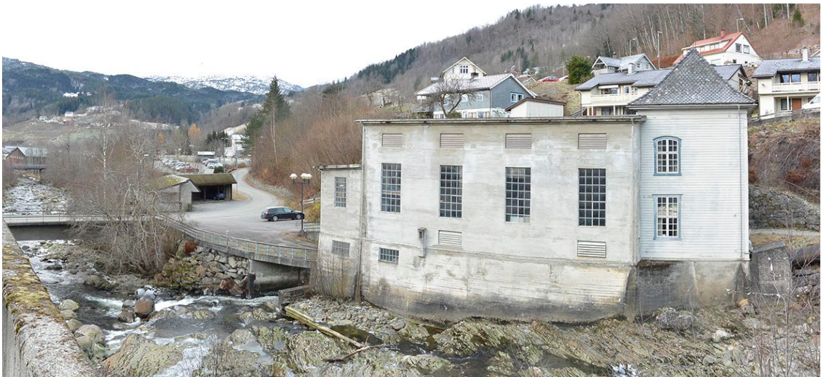
Figur 2-10: Etter utviding på 50-talet står den øvre delen igjen som den einaste originale, med trekledning. Ny bygningsmasse har eit meir funksjonalistisk preg og er utført i betong. Hovuddelen er vorten både breiare og lengre, slik at kraftstasjonen har sprang i sideretning og beslaglegg større del av elveleiet. Elveleiet har lite kantvegetasjon.
