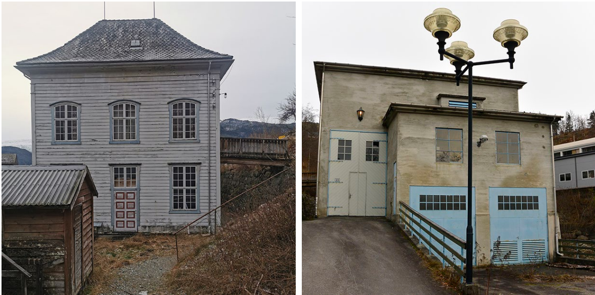
Figur 2-11: Original del frå 1923 til venstre og sørenden av ny søre del, der portane inn i kraftverket er.
