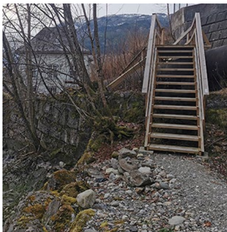
Figur 2-2: Eksisterande situasjon, med gangveg som ber preg av at elva eroderer under flaum.
