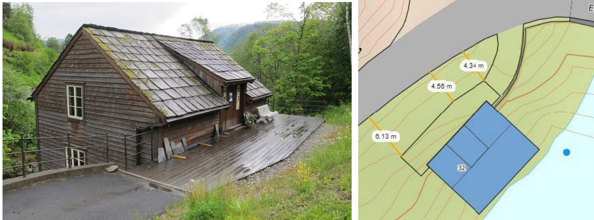
Figur 2-3: Tilkomst med stor transport og tunge køretøy lyt skje via gangtrase forbi Skeie-Mylna. Profilet forbi bygningen er trangt og traseen går i dag over eit dekke som og tener som overbygg for gamle, underliggende konstruksjonar, tilhøyrande mølla. Figuren til høgre syner at breidda på skråninga mellom dekke og fylkesvegen variera mellom 4,5 og 6 meter, der hellinga jamt over er 1:2.
