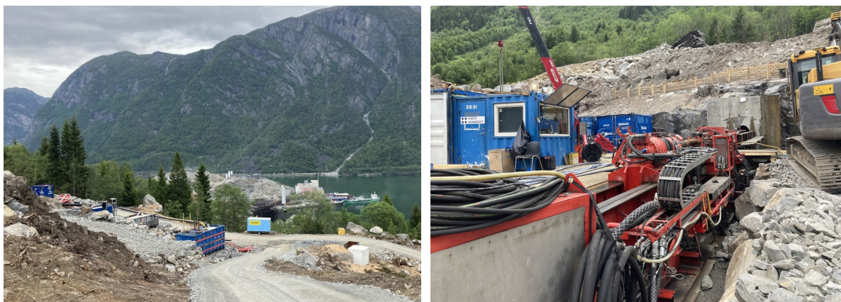
Figur 2-7: Bileta, tekne frå ein tilsvarande borerigg gjev eit inntrykk av arealet som lyt til for å få til ein funksjonell rigg. Visse tilpassingar til den enkelte staden vil ein kunne få til, men arealbehovet og ikkje minst åtkomstbehovet vil være avgjerande for kva kulturminne ein kan ivareta og i kva grad.
