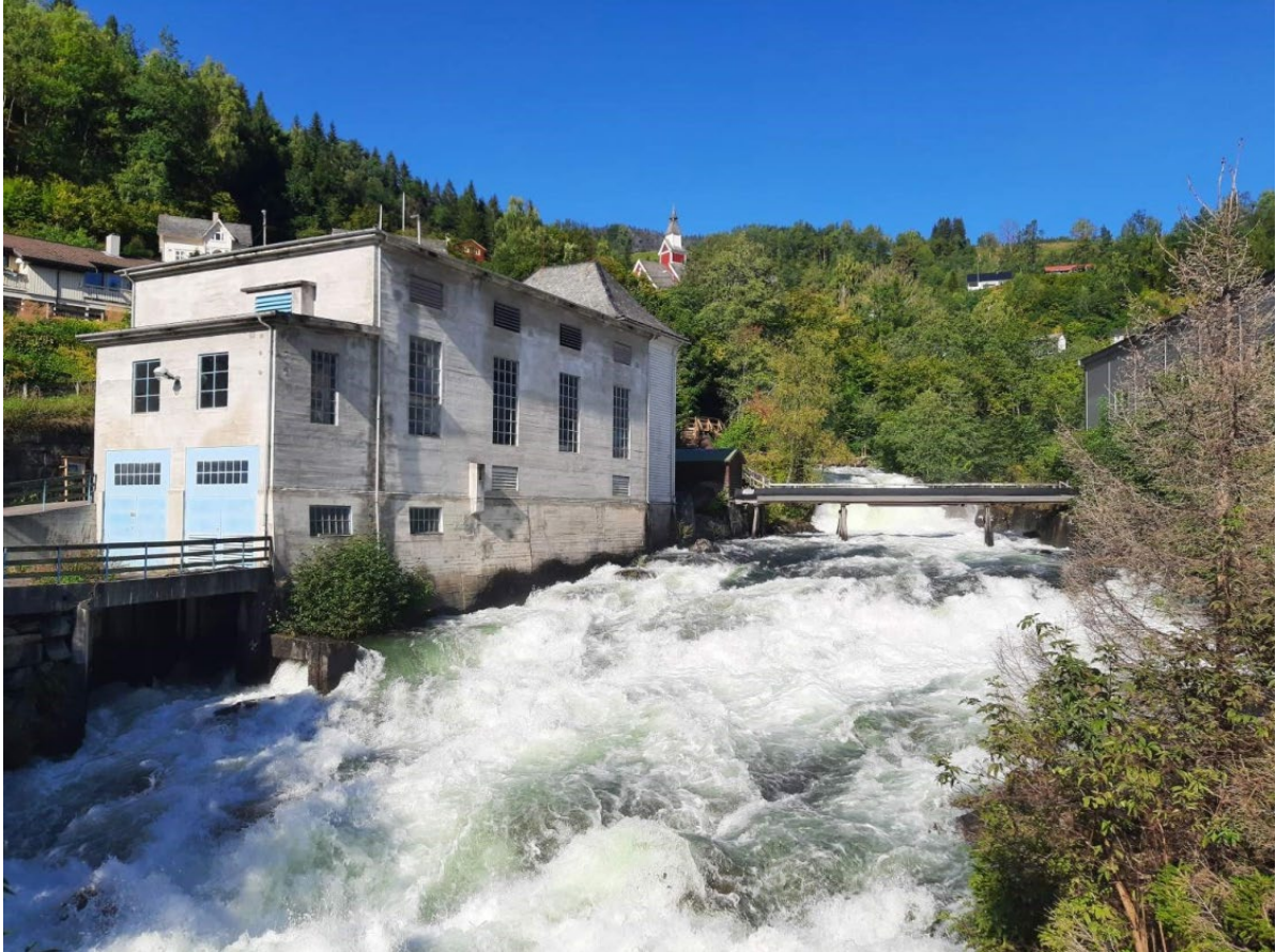
Figur 2-8: Biletet syner elva med høg vassføring forbi kraftstasjonen. Vassføringa er betydeleg større i flaumsituasjonar.
