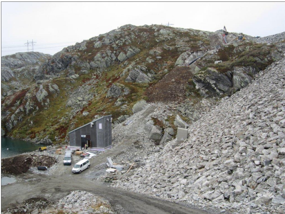
Figur 5. Grasbotntjørni pumpe i Eidfjord kommune under bygging. Eksempel på utforming.
