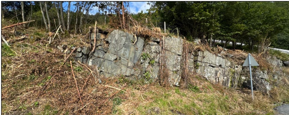
Figur 6: Bergskjæring nord for kartleggingsområdet ved gbnr. 54/4, sett mot nord-nordvest.
