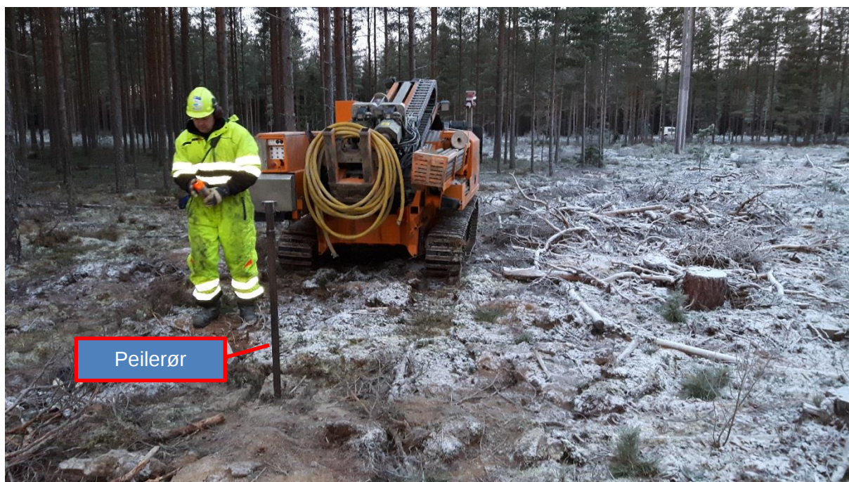
Bilde 2: Borerigg. Nedsatt peilerør.
