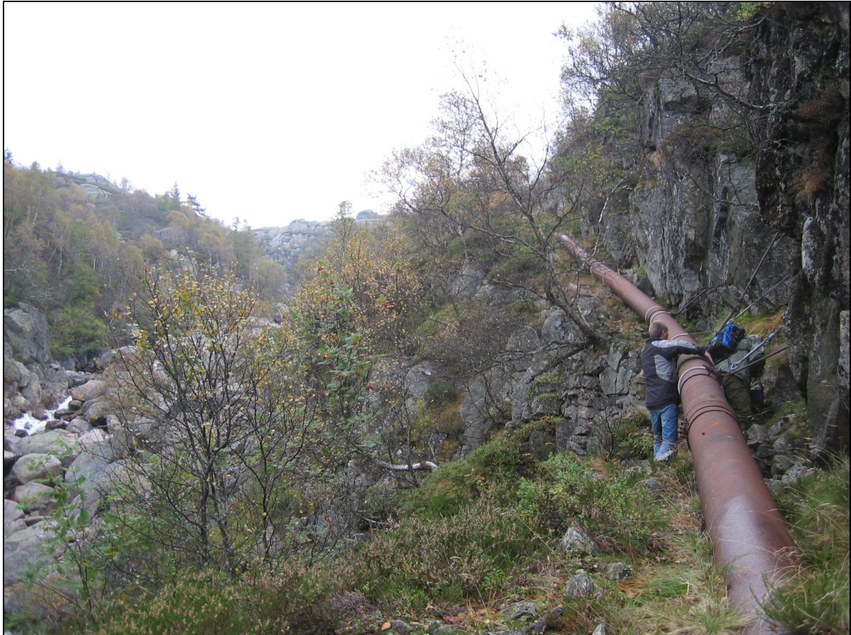
Bilde 3. Parti fra de nedre delene av tiltaksområdet. Rørgaten fra tidligere kraftutbygging ses til høyre i bildet.
