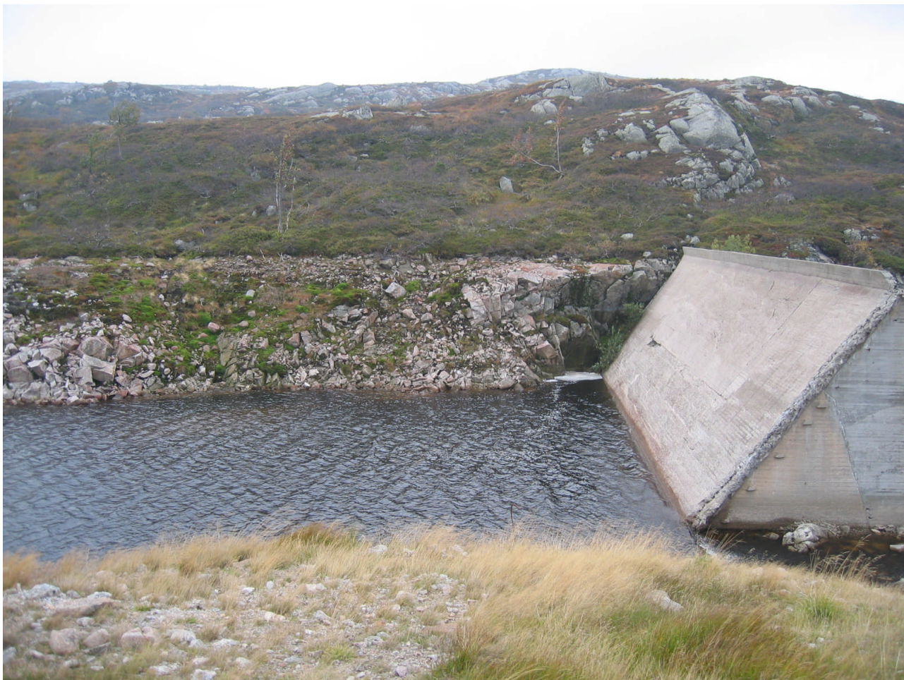
Bilde 1: Inntaket plasseres i forbindelse med dam.
