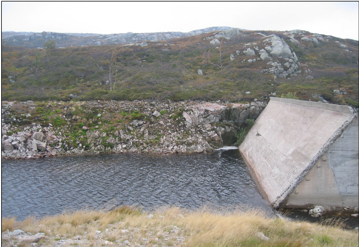
Bilde 8. Deler av den gamle reguleringssonen. Tilsvarende areal vil bli satt under vann dersom utbyggingen finner sted. Restene etter gammel dam ses til høyre i bildet.
