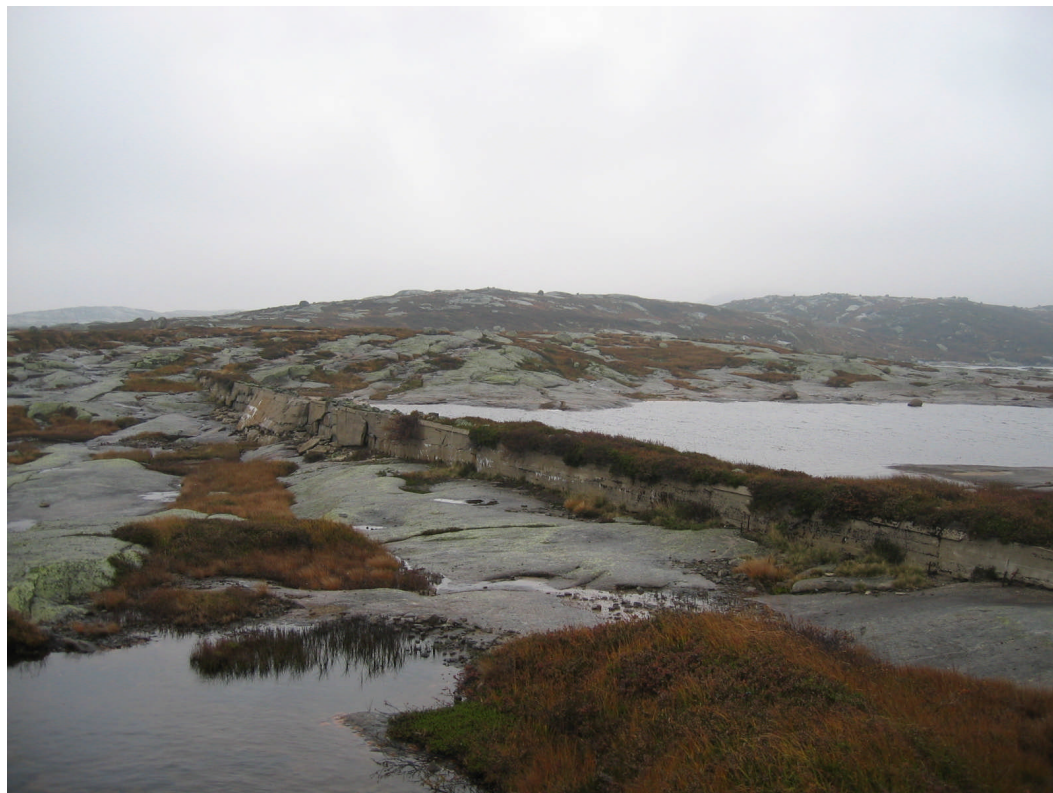
Bilde 8: Eksisterende vestre dam ved Bergetjørn.
