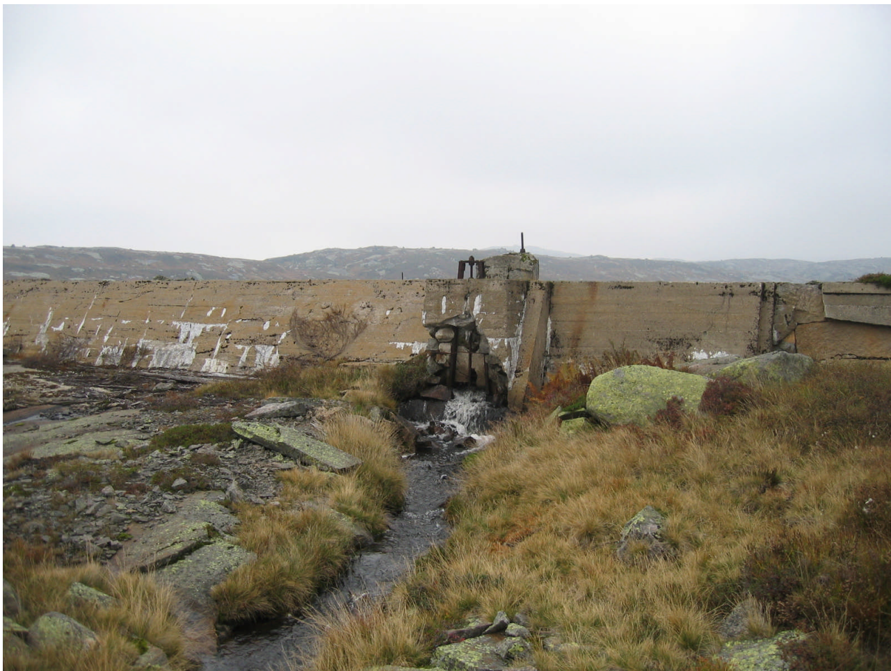
Bilde 3: Eksisterende østre damanlegg, med luke, for nabofeltet Bergetjørn som blir opprustet.
