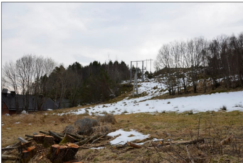
Figur 28. Bilde av tomt hvor ny Bruvoll transformatorstasjon skal plasseres.
