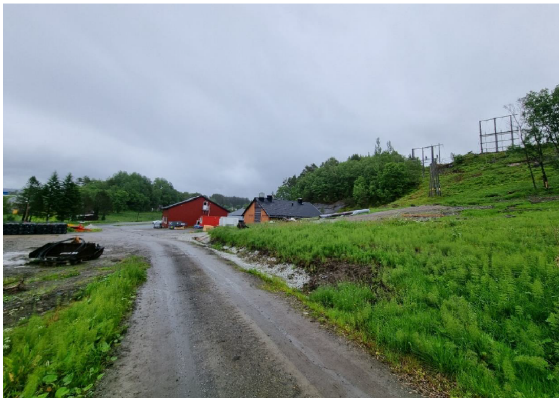
Figur 26. Foto ved dagens Bruvoll trafostasjon.
