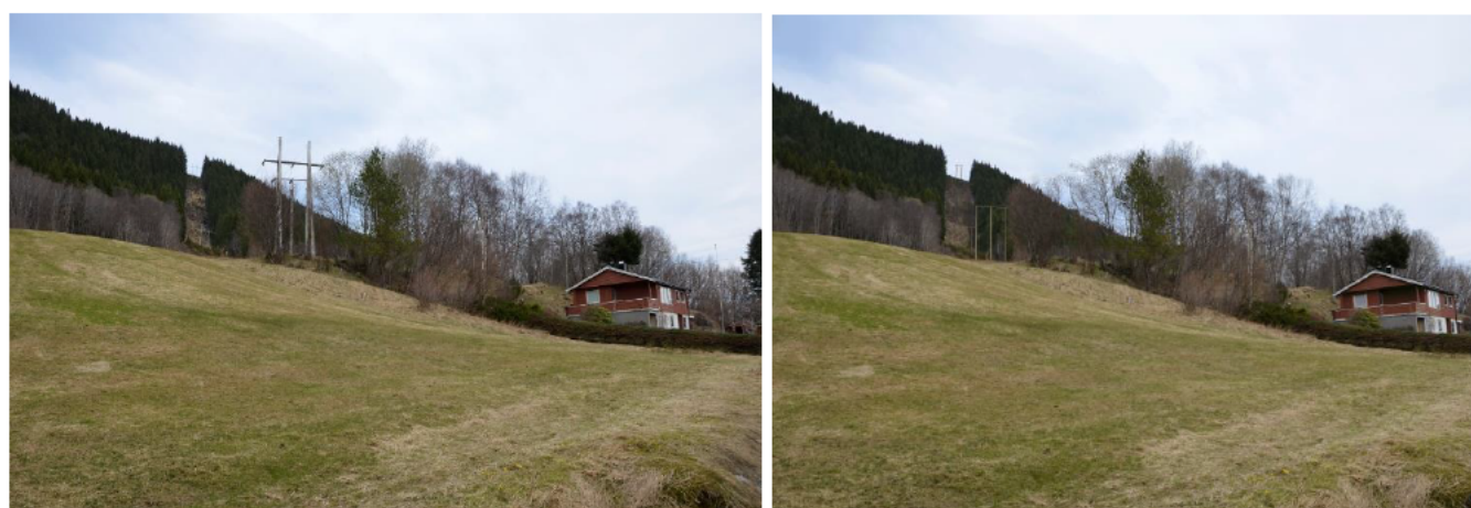
Figur 25. Eksisterende 66 kV-linje til venstre og ny visualisert 132 kV-line til høyre ved kabelendemast på Rokset.
