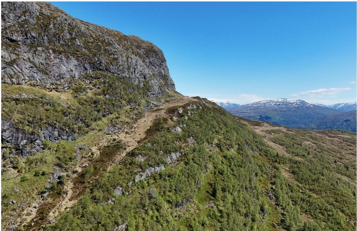
Figur 5: Dronefoto tatt mot øst som viser de to største brattpartiene/skrentene og den brede mellomliggende avsatsen som avskjærer mot vest. En ser også mulig dominerende sprekesett ved avsatsen som bl.a. omtrent følger avsatsens fall og fallretning, og de begrensede uravsetningene. Kartleggingsområdet er utafor høyre billedkant.
