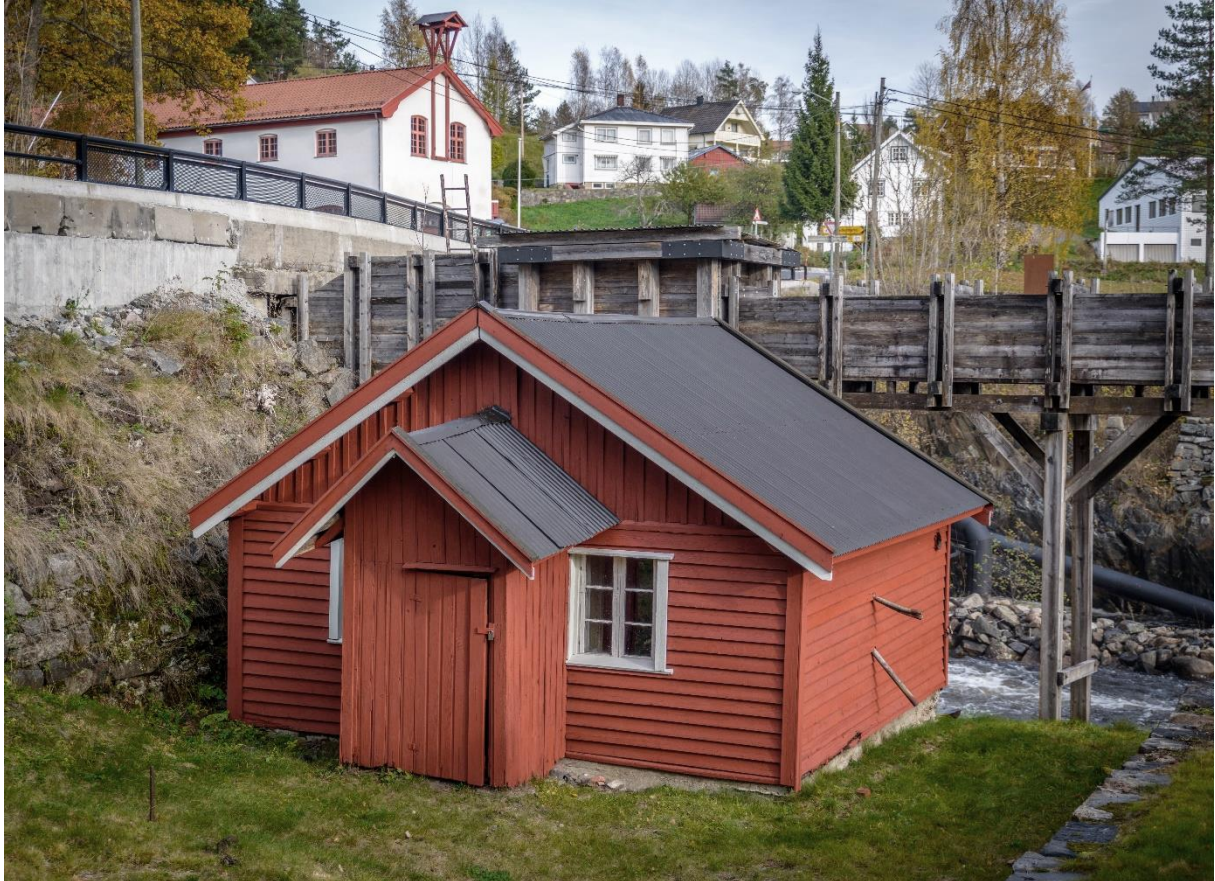
Eksisterende kraftstasjon fra 1916 skal bevares så autentisk som mulig, og er inspirasjon for eksteriørmessig utforming av den nye kraftstasjonen.
