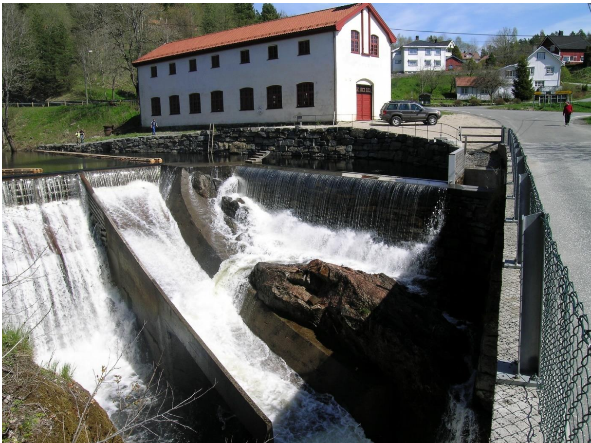
Fig 4. Rekonstruert tømmerkistedam og nyetablert sidekanal med flomoverløp.
