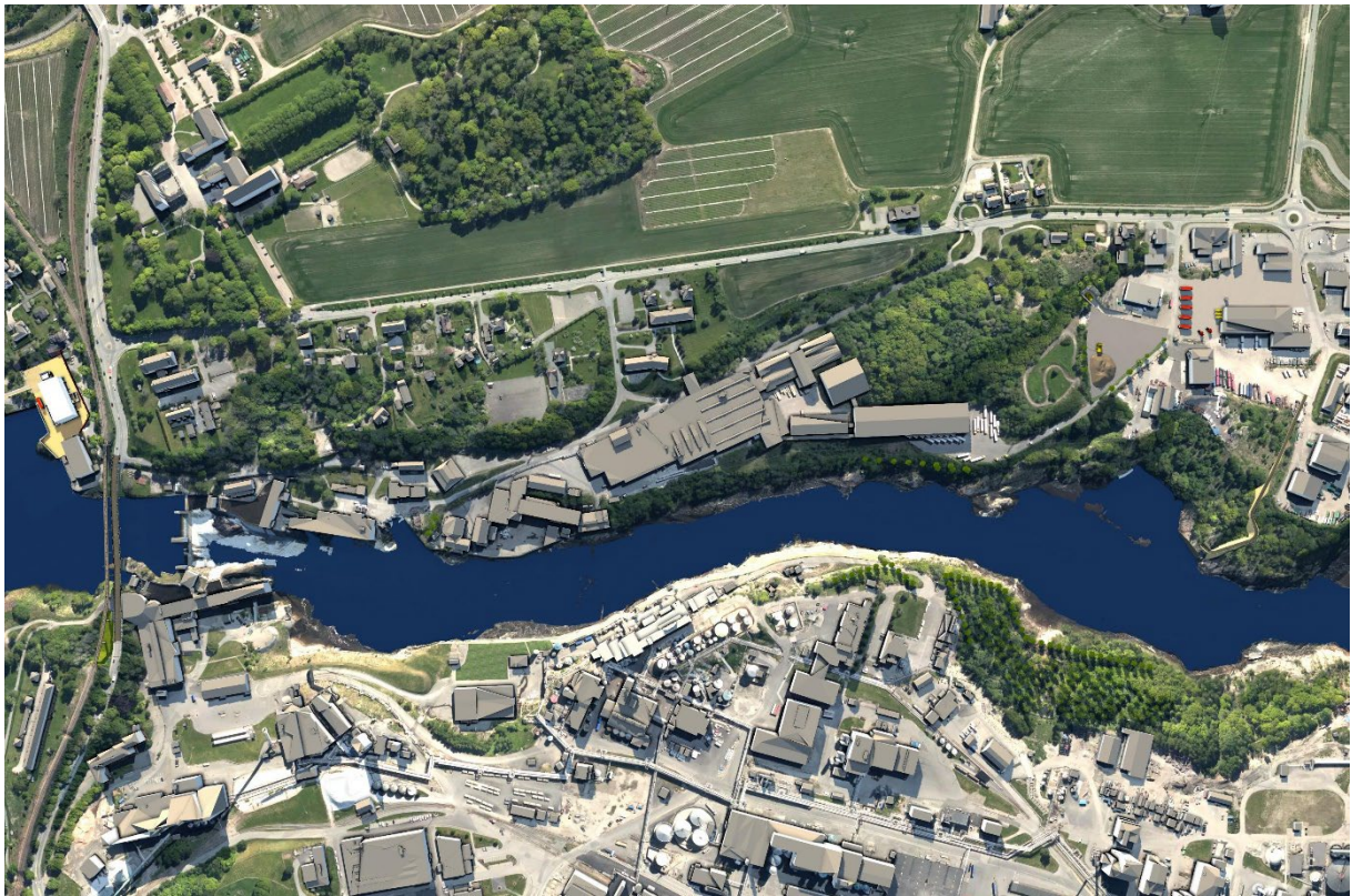
Figur 5-9 Totalvannføring 550 m 3 /s, 350 m 3 /s går i Sarp 2 og 200 m 3 /s går i elveløpet. Visualisering: Norconsult
