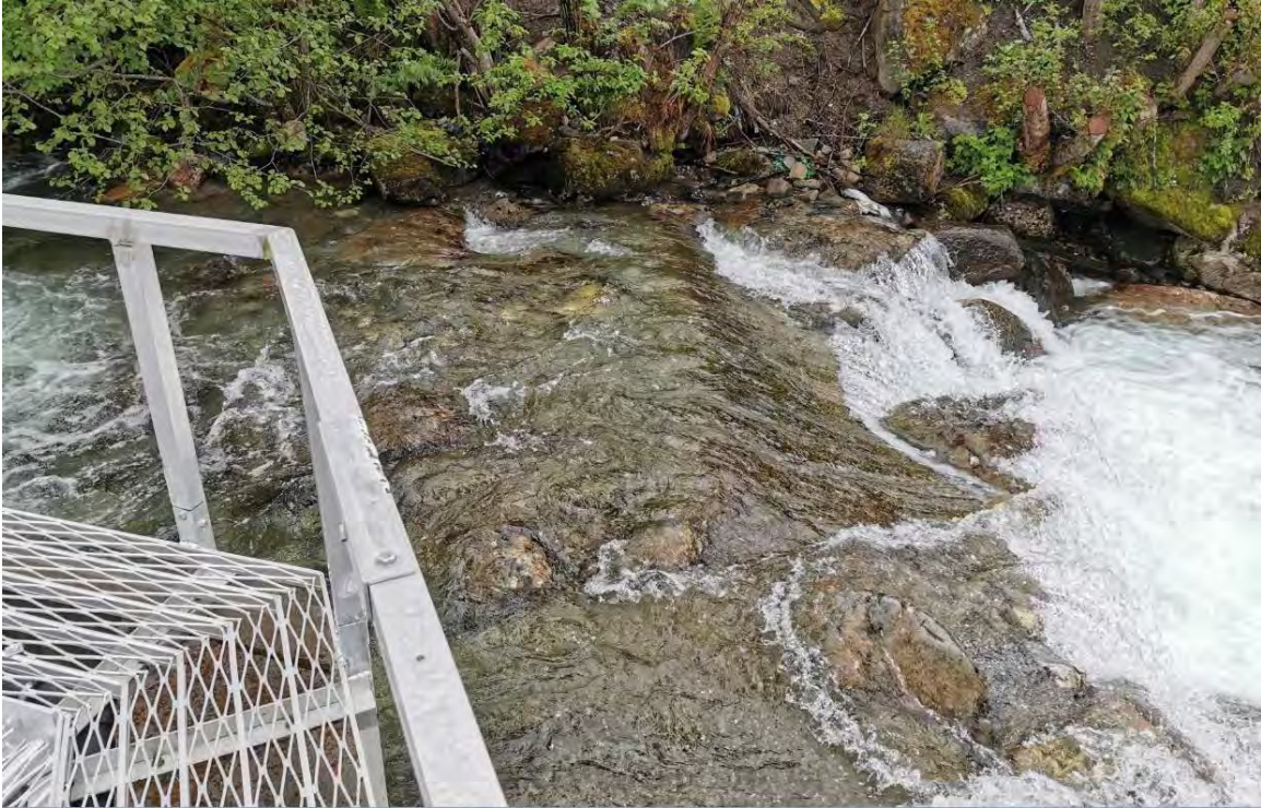
Bilde 5 – Terskel rett nedstrøms inntaket
