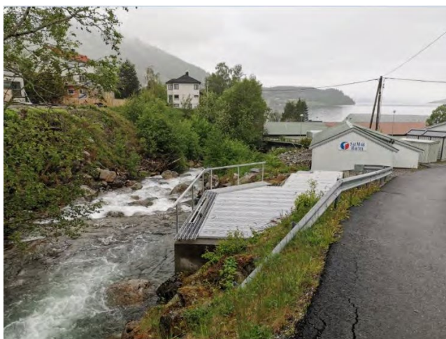
Bilde 1. Eksisterande vassinntak i elva og inntakshus.
