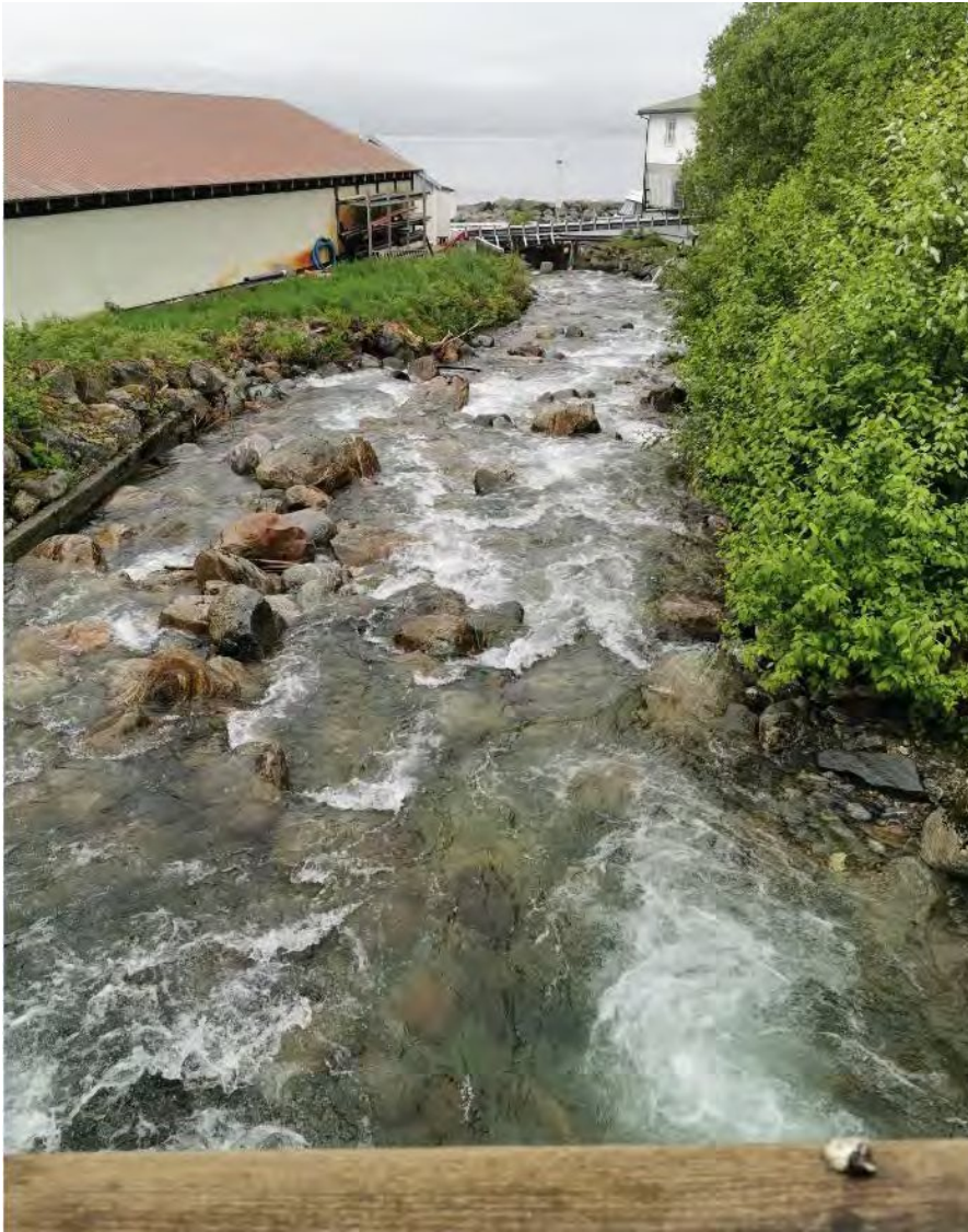
Bilde 7 – Råka elvestrekning sett fra kryssande Ø400 mm rørgate og medstraums mot bru mellom anleggsområda, og utløp til sjø.
