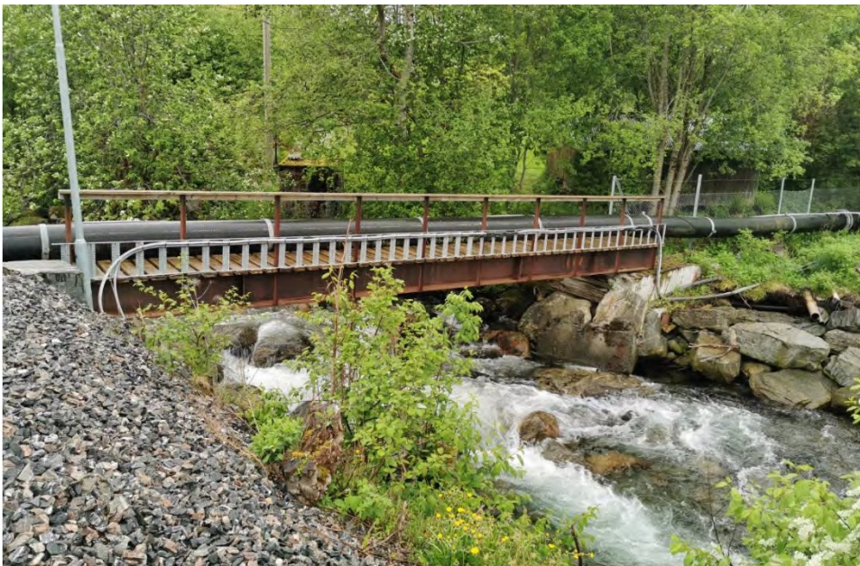
Bilde 9 – Elvekryssing for Ø400 mm røyrledning
