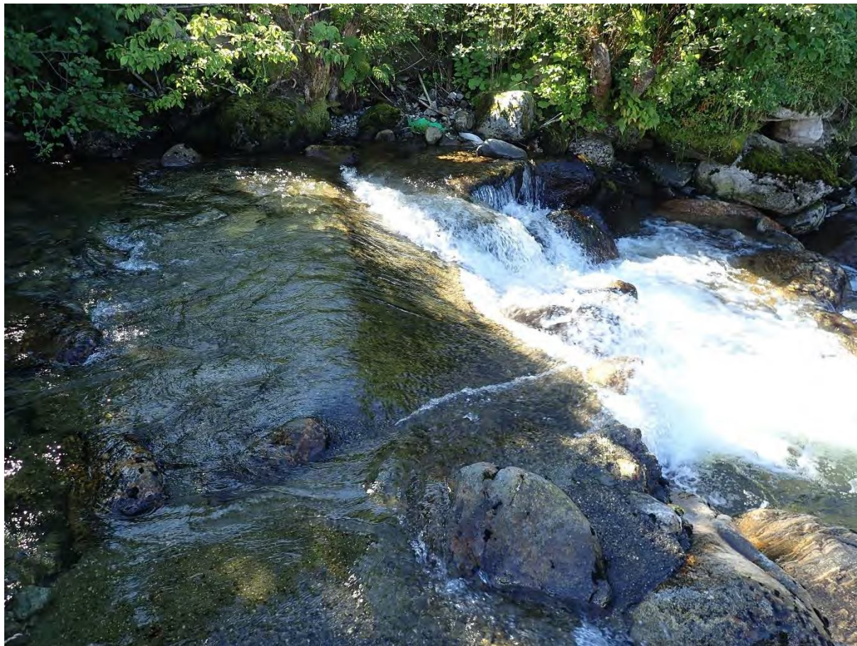
Figur 8. Oppmurt terskel nedenfor vanninntak for stamfiskanlegg.
