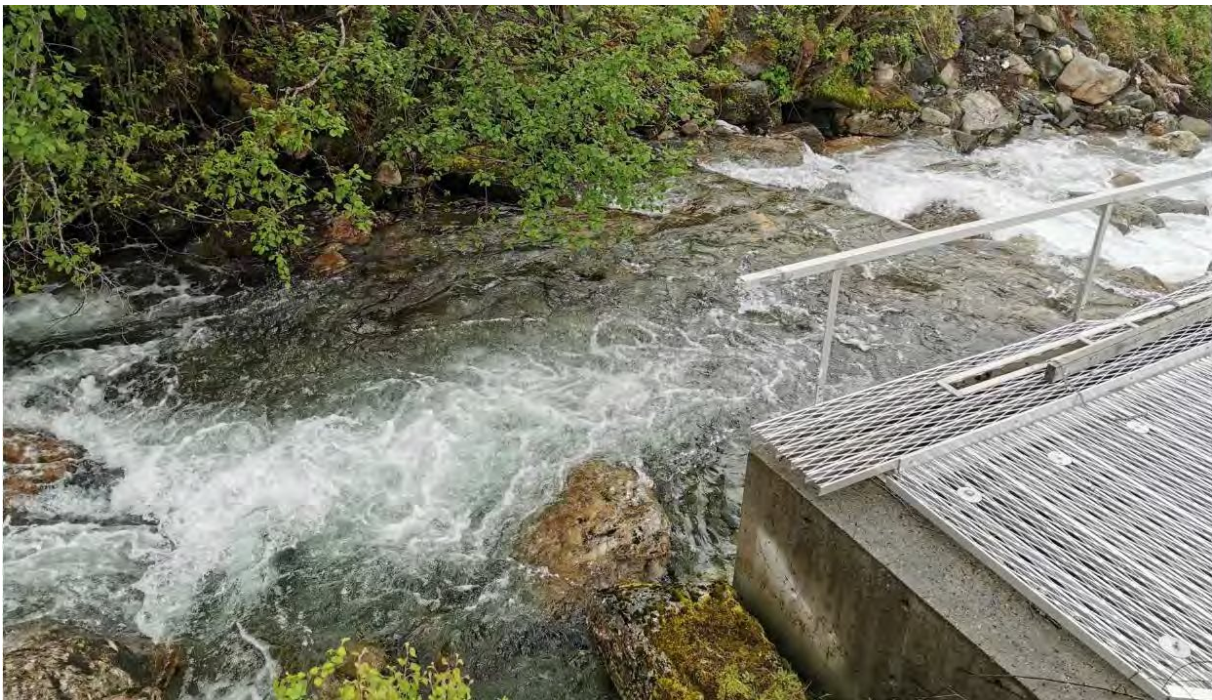
Bilde 4 – Kulp framom inntaksrenne
