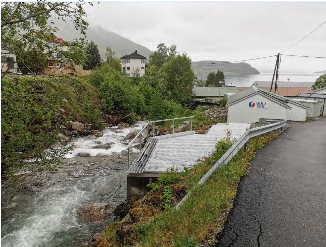
Bilde 1 – Inntaket sett rett oppstrøms
