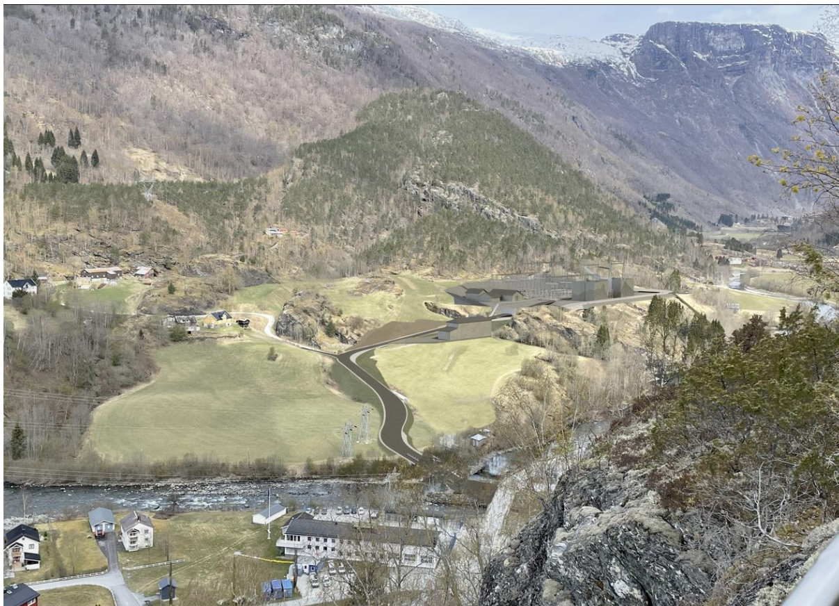
Figur 2 Transformatorstasjon. Kilde: Visualisering av Sweco.
