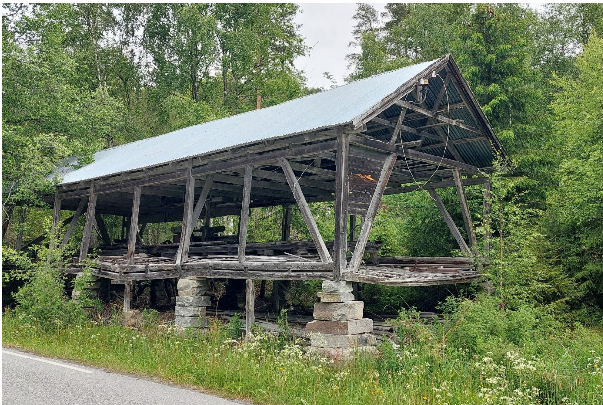
Figur 36, bygg som skal rives ved etablering av kraftstasjon. Foto: Linn Eilertsen.
