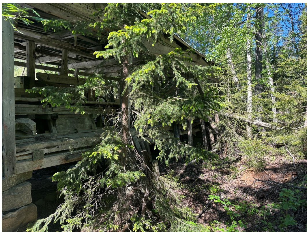
Terrenget bak kraftstasjonen
