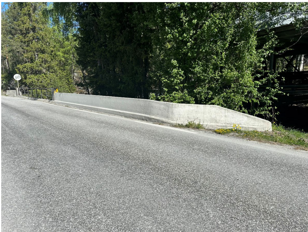
Kraftstasjonen kommer på høyre side av vegen, bilde tatt mot nord
