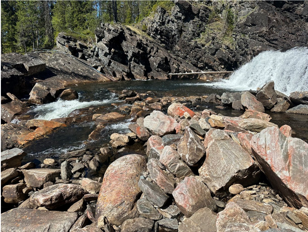
Det er planlagt en terskel der vannspeilet bryter, planlegger å heve vannspeilet med 0,5 m for å sikre tilstrekkelig dybde, inntaket kommer til høyre i bildet, bilde tatt mot nordvest
