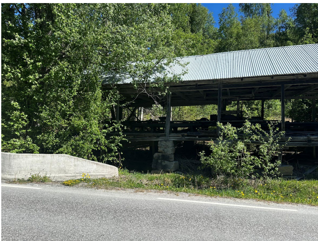
Kraftstasjonen kommer der den falleferdige sagen står, bilde tatt mot nordøst
