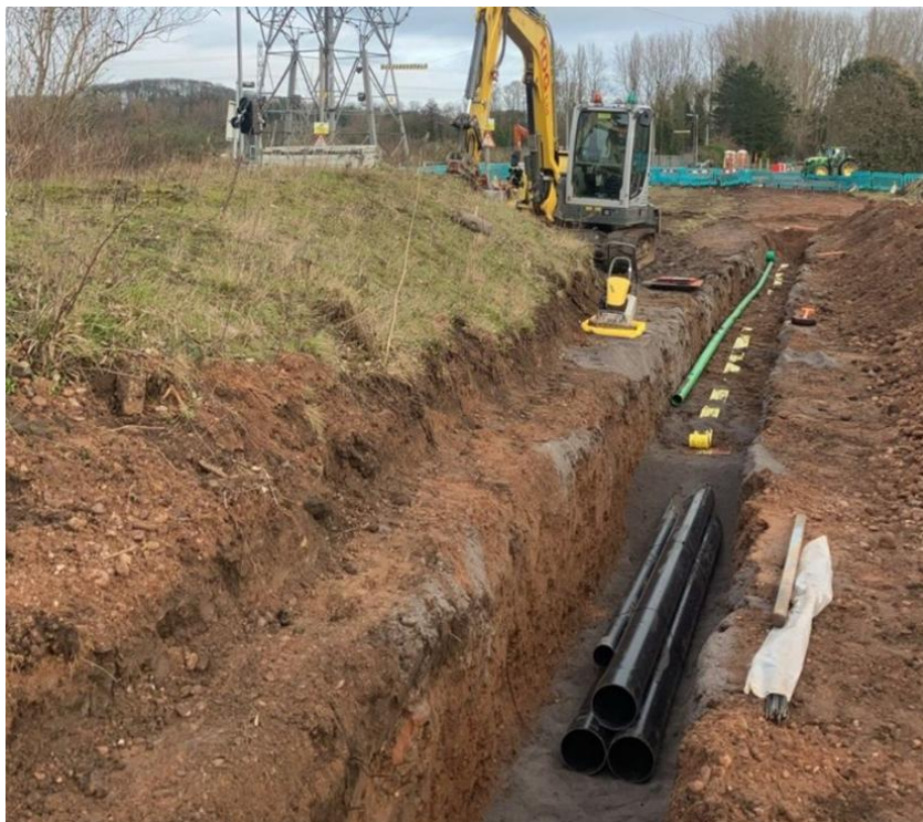
Figur 6. Nedgraving av strømkabel. Bilde oversendt av Statnett.
