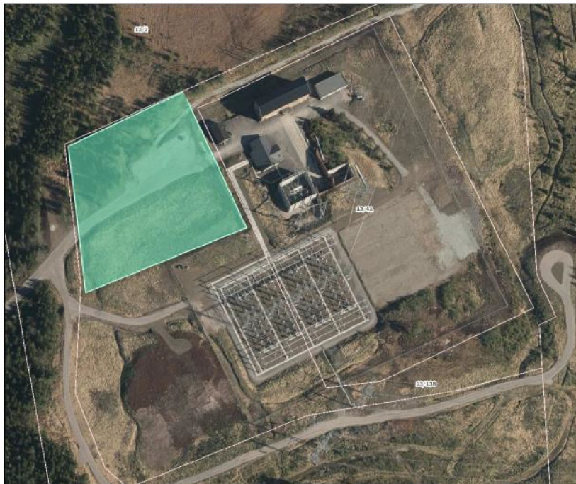
Namsos S (Skage) transformatorstasjon. Området som er markert er satt av for ny 132 kV koblingsanlegg.
