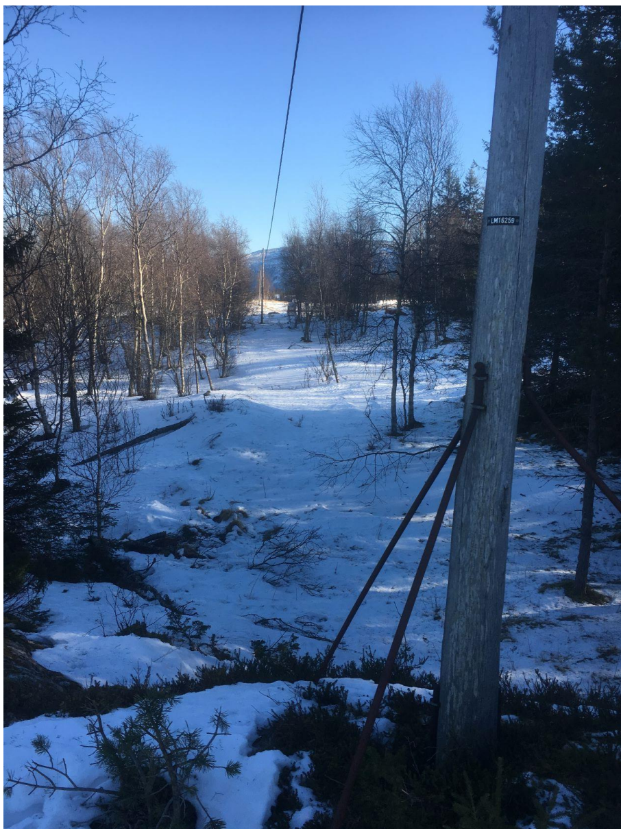
Figur 8 Eksisterende lokalnett. Jordbruksområde på eiendom gnr./bnr. 86/2 skimtes i bakgrunnen.
