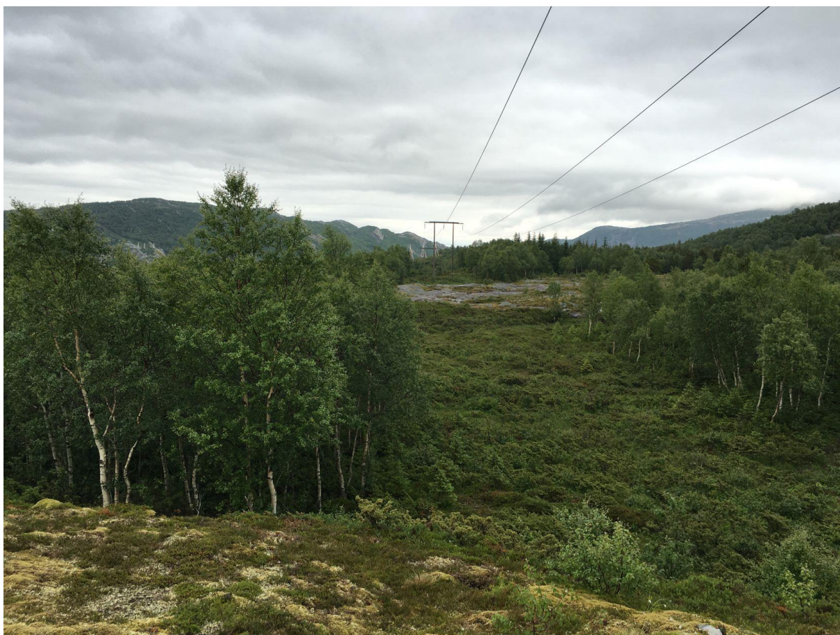
Figur 11 Eksisterende 132 kV sett fra nord mot sør. Adkomstvei vil krysse under nett-trasé.
