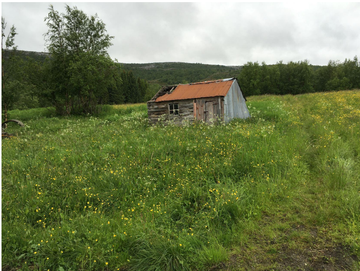
Figur 6 Gammelt fjøs/uthus på eiendom gnr./bnr. 86/2. Adkomstvei og stasjon vil bli liggende hhv. 140 og 300 meter bak bygning i luftlinje.
