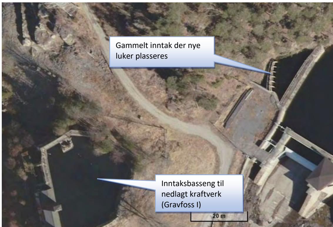
Figur 3. Flyfoto. Gammelt tunellinntak til høyre i bildet der nye luker vil plasseres. Tunnelen ender ut i inntaksbassenget til venstre i bildet.
