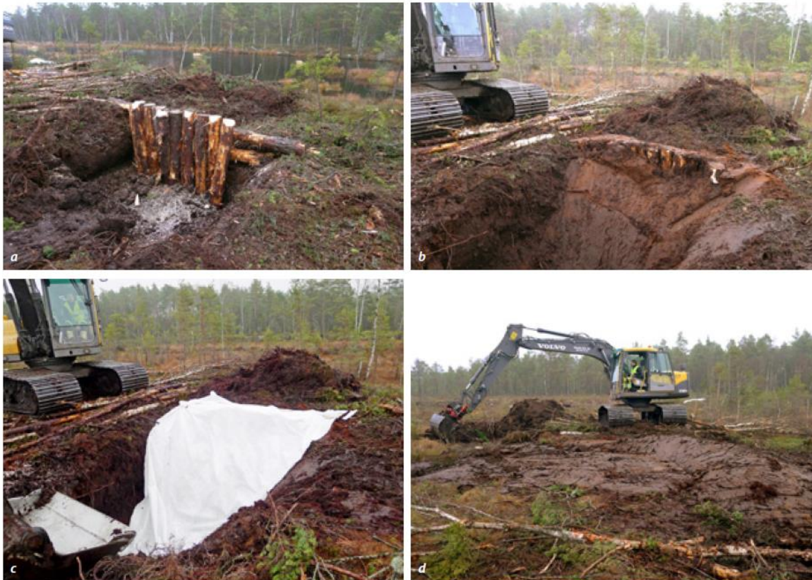
Figur 21: Eksempel på sperre av bekkeløp ved bruk av tømmerstokker og membran. (Rova & Paulsson, 2015)
