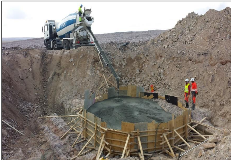
Figur 3-1. Støping av turbinfundament i Raggovidda vindkraftverk. Mest sannsynlig vil det bli valgt samme type fundament på Dønnesfjord II vindkraftverk. Foto: Multiconsult Norge AS.
