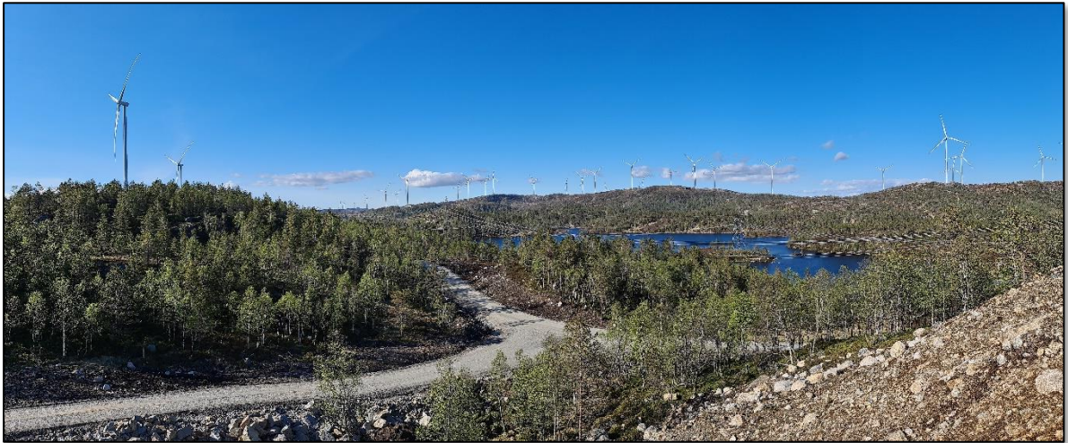
Figur 3-3. Internveier i Tonstad vindkraftverk. Foto: Multiconsult Norge AS.
