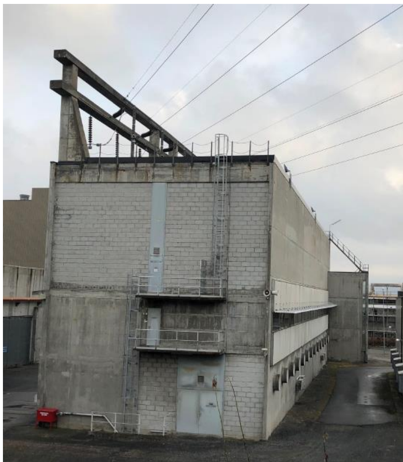
Figur 3-1. Rafnes transformatorstasjon (PDC).
