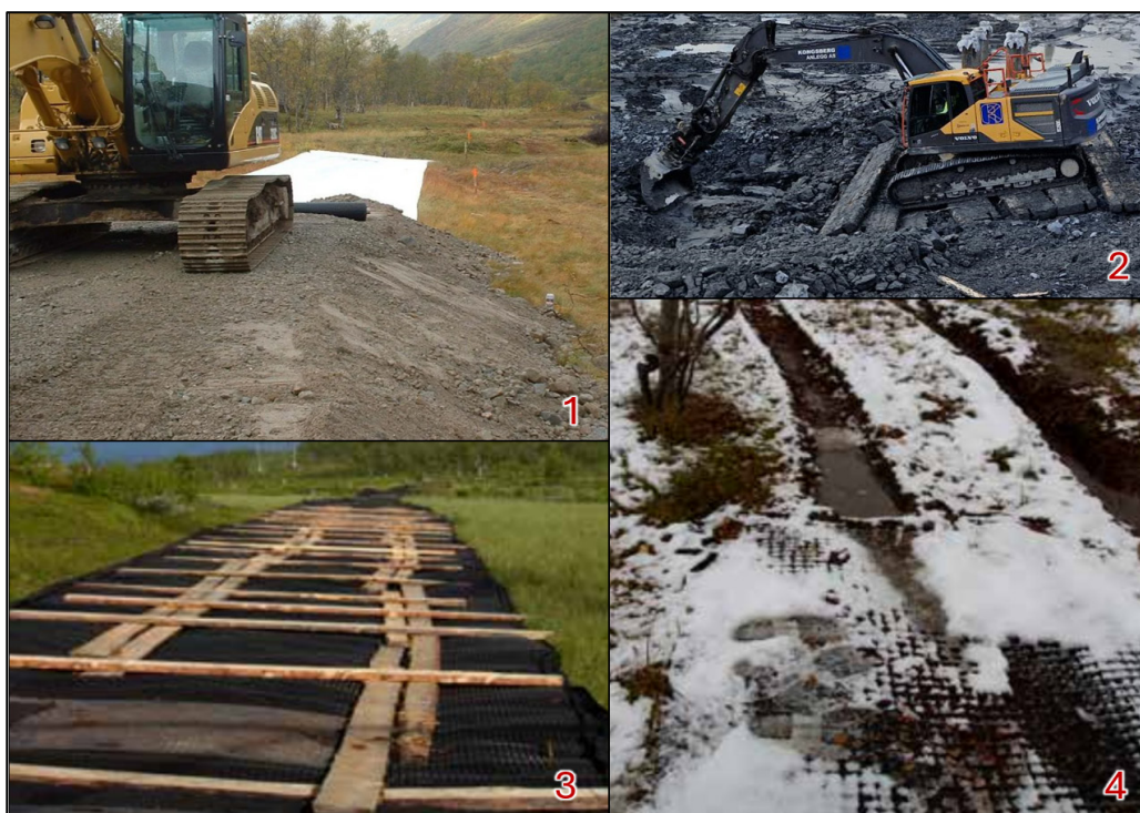
Figur 5-3 Eksempler på ulike løsninger for etablering av anleggsvei. Merk at løsninger som egner seg på flatt terreng ikke nødvendigvis egner seg like bra i bratt terreng. Bilde (1) viser utlegging av vei med fiberduk, geonett og fyllmasser ( Dahl.no ), (2) bruk av stokkmatter på bløt leire (NGI), og (3-4) geonett med og uten planker/ol. ( NVE.no - «god praksis nr. 9»).
