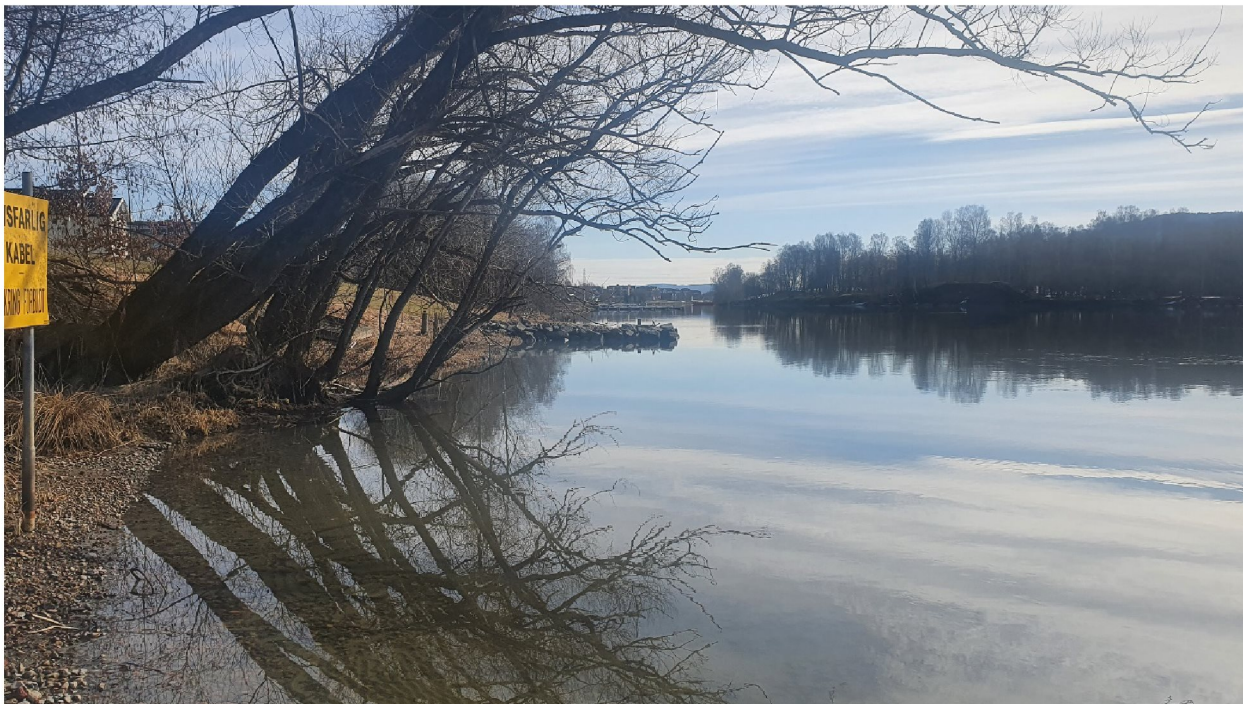
Figur 2.8 Ingen pågående erosjon langs Drammenselva
