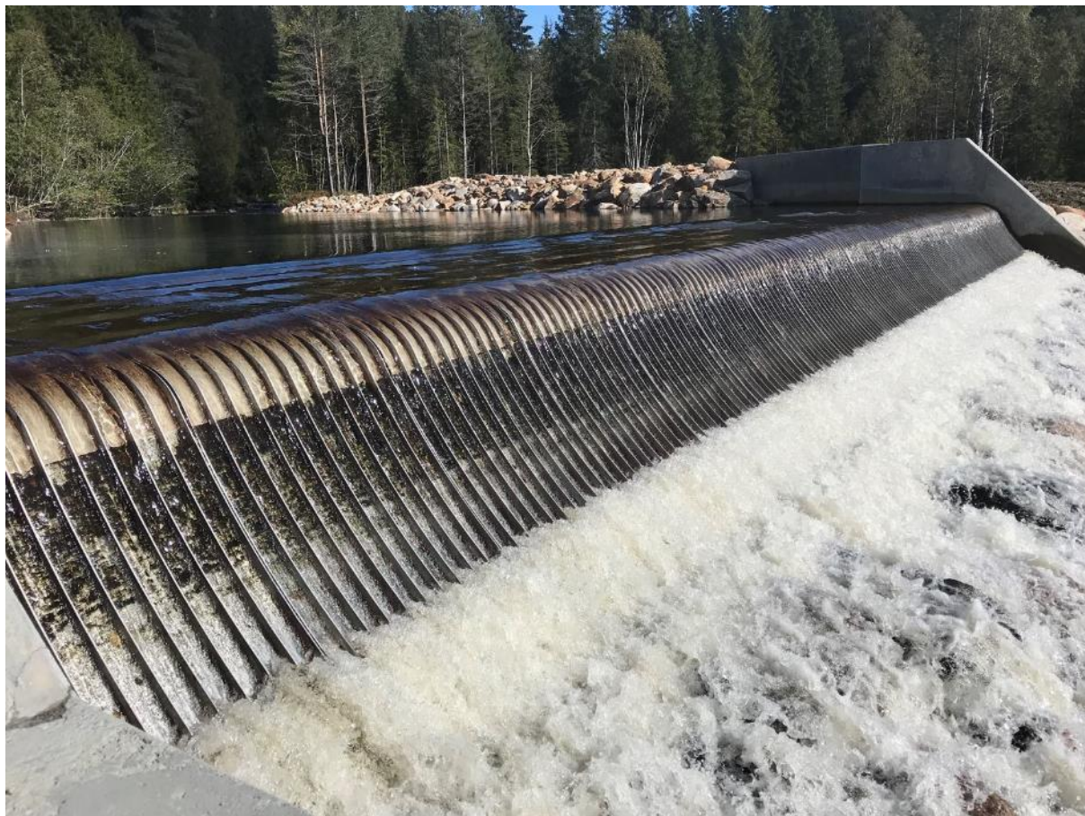
Figur 11 - Eksempel på overfallsinntak, her vist som Coanda. Foto: Lars Midttun, NVE ( www.nve.no )
