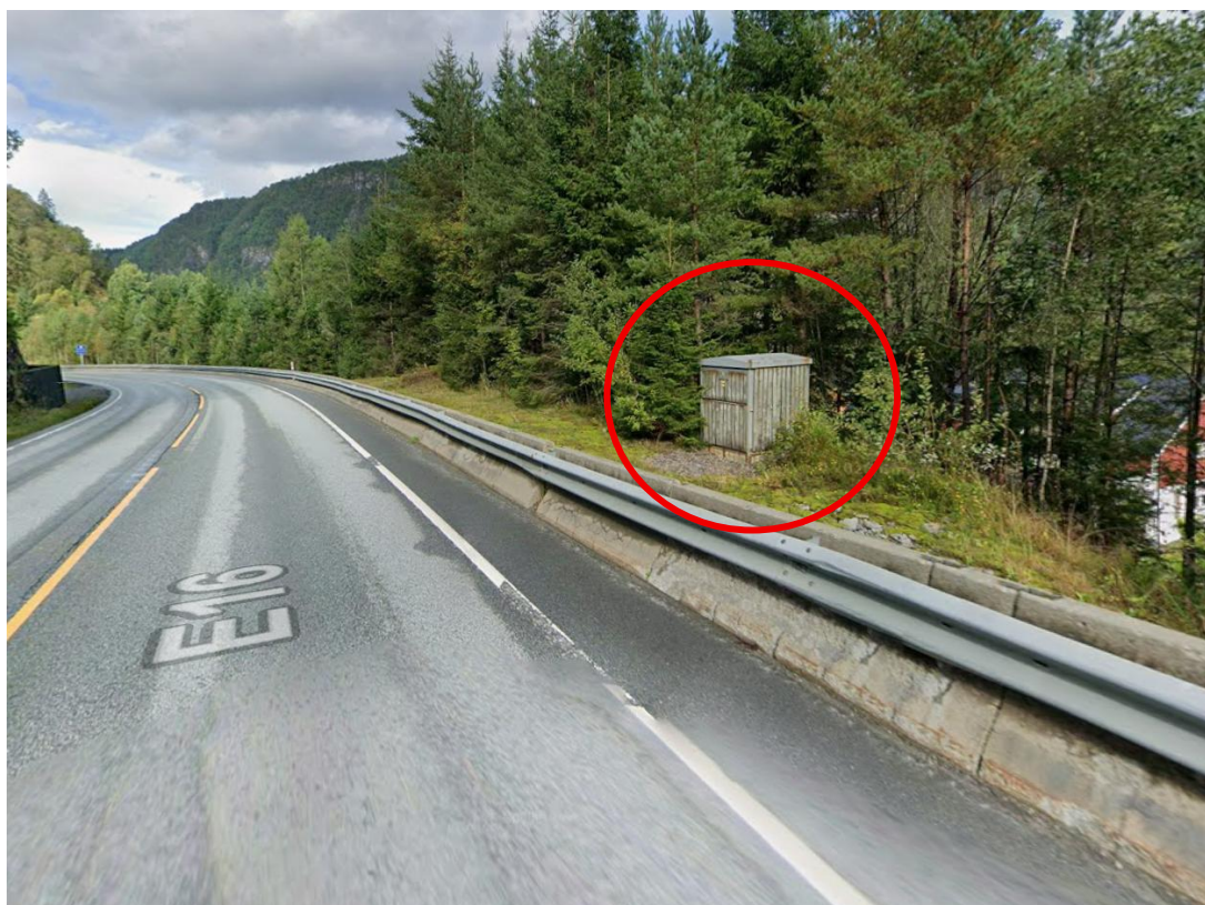
Figur 28 - Eksisterende nettstasjon for planlagt tilknytning med rød ring rundt. Bildet hentet fra google maps 12.11.2025. Tilknytningen kommer fra motsatt side så vei blir ikke berørt.
