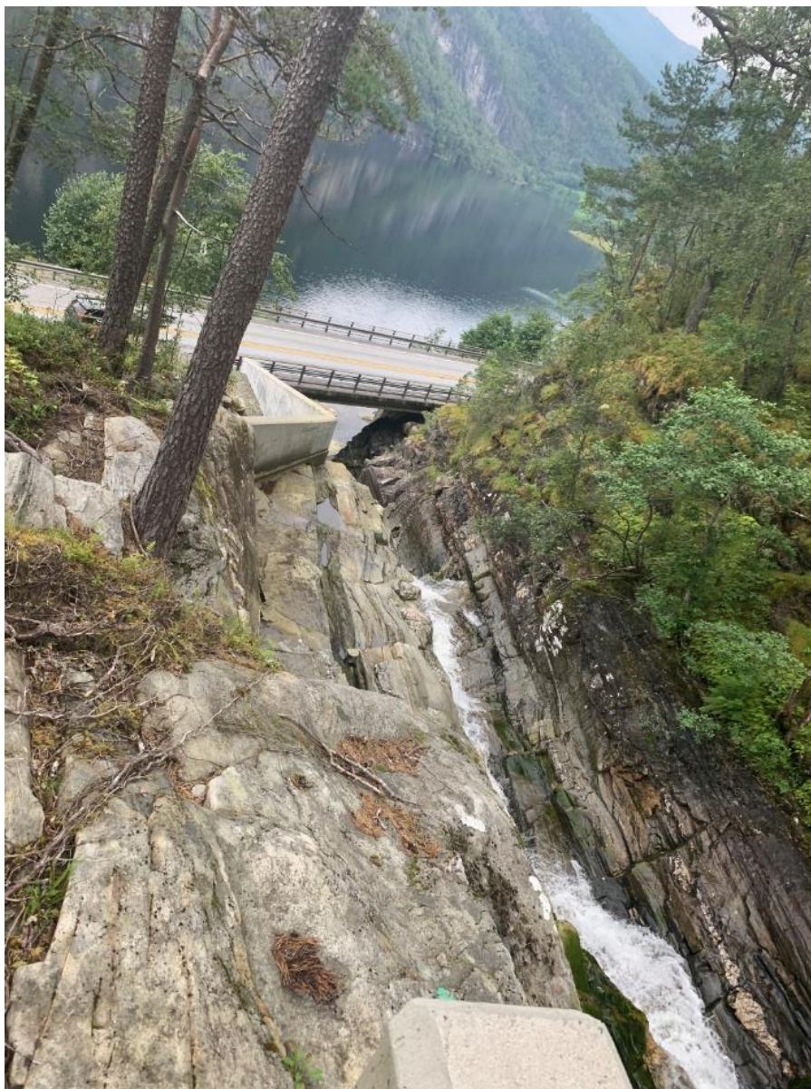
Figur 3 - Geitelvi sett fra øvre flomvern ned mot bro der E16 krysser Geitelvi. Forbygning sees ovenfor bro på E16
