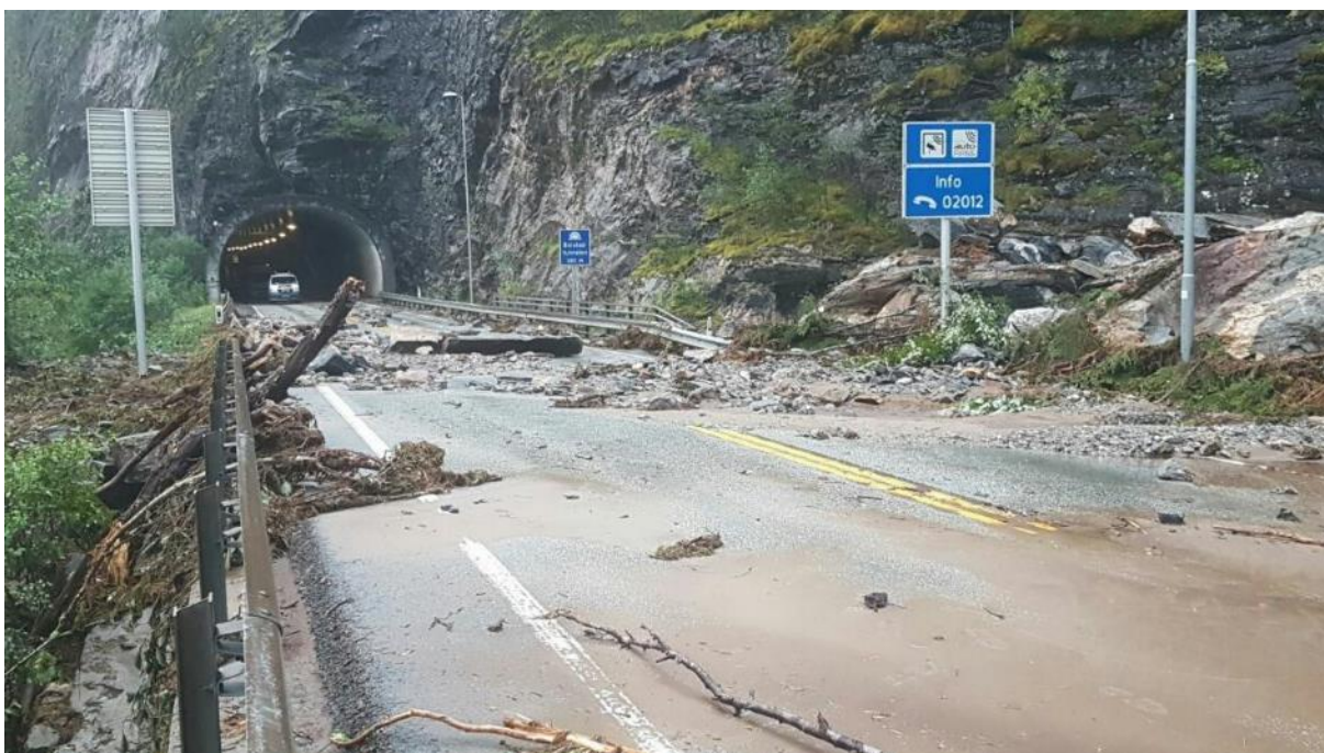
Figur 32 - Flomskred 28 august 2019. Bru/rekkverk over Geitelvi sees midt i bildet. (Kilde: www.vg.no ). Traktorvei går opp helt til høyre i bildet.
