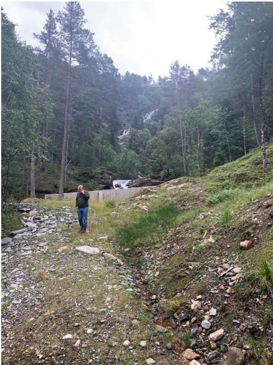
Figur 4 - Geitelvi med foss i bakgrunnen. Forebygging i betong sees i bakgrunnen.
