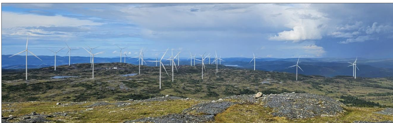
Figur 1-3 Viser det omsøkte tiltaket med 180 meter høye turbiner.
