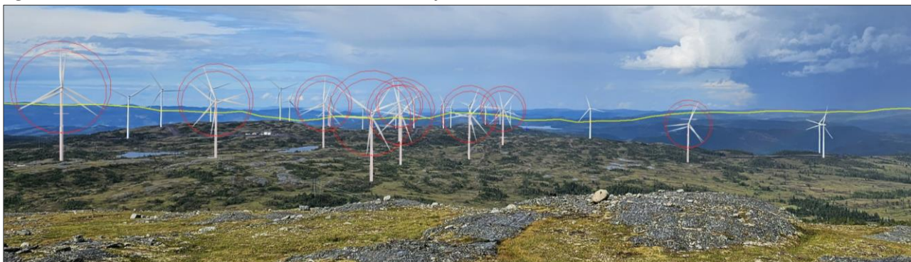
Figur 1-5 En sammenligning mellom turbinhøyde 180 meter og 195 meter er vist ved røde sirkler.
