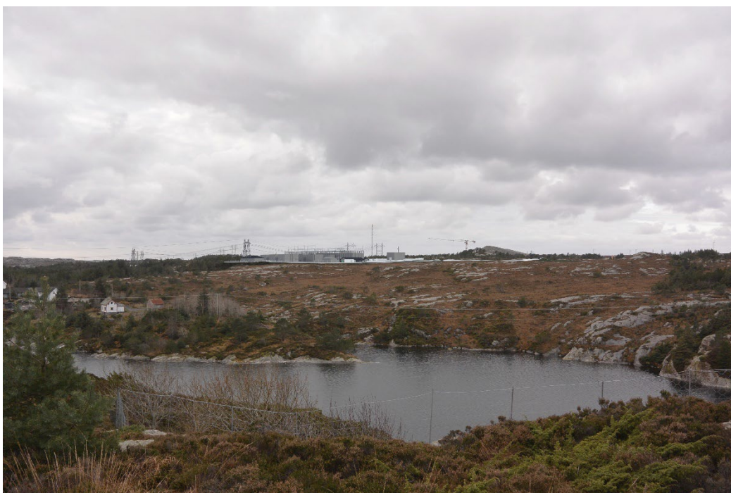
Figur 22: Visualiseringen viser omsøkt stasjonsutforming hvor 420 kV og 300 kV anleggene er samlet i et felles bygg. Se også vedlegg 8 for visualiseringer. Kilde: Sweco, 2023.
