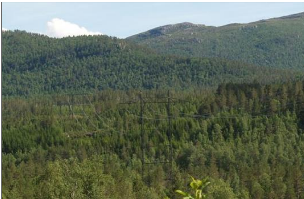
Figur 11. Bilde av kamouflert kraftledning. Mastene er grønnmalt, linene er mattede, og isolatorene er av kompositt i stedet for av glass som er vanligst å benytte
