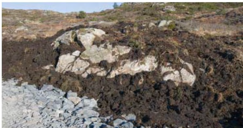
Figur 3-8 Rundt utstikkande nabbar kan det leggast masser rundt, med tjukkare lag i botnen og tynnere på toppen.
