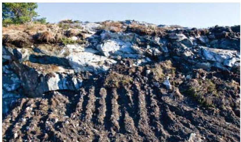
Figur 3-5 Unngå tannmerker etter gravemaskinskuffe. Overflaten rufsast til.
