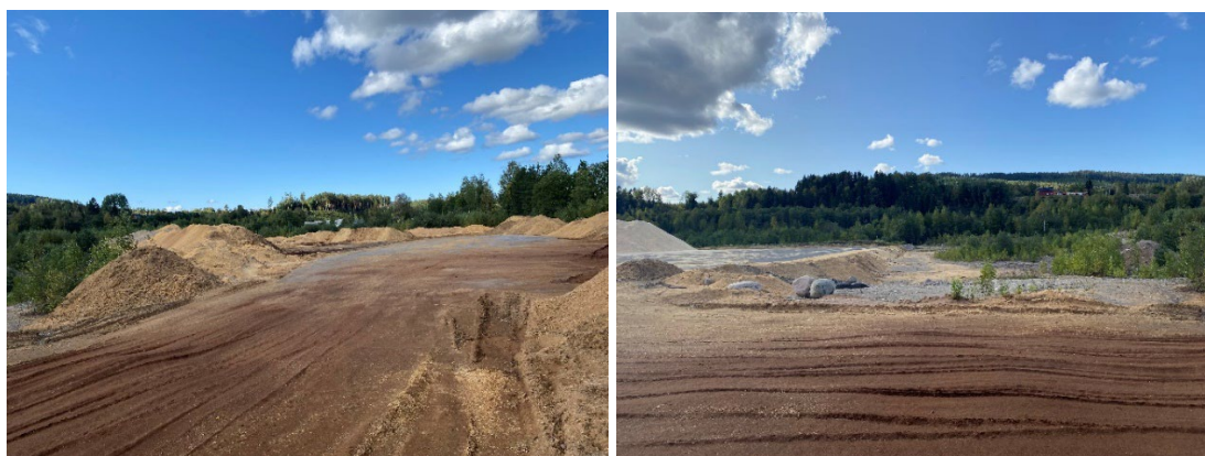
Figur 7. Bilder fra det vestre området for Grasmo Solkraftverk
