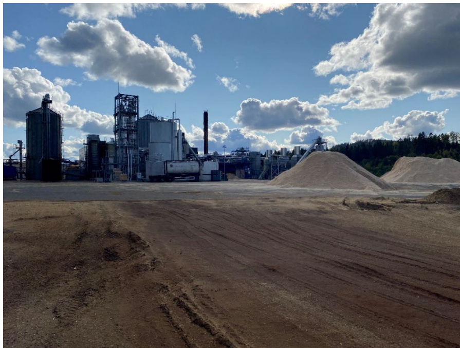
Figur 8: Utsikt i retning ArbaOne – rett syd for planlagt område for solkraftverket
