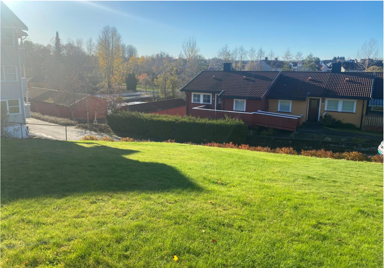
Figur 12 Bildet viser skråning i beregnet snitt. Bildet er tatt fra tomten Stasjonsgata 22.
