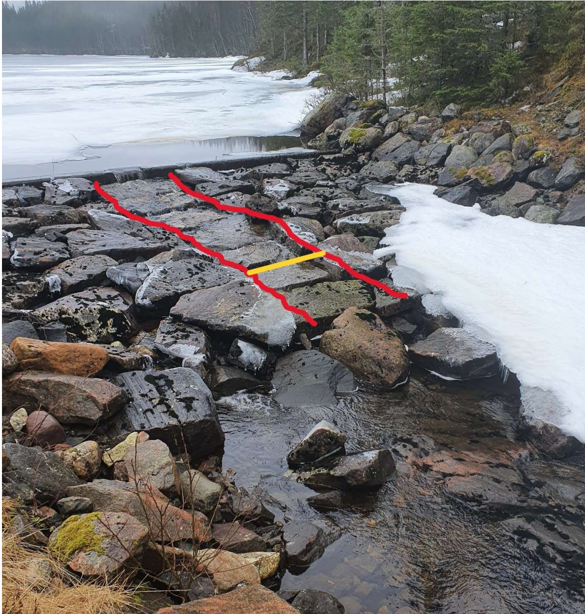
Figur 4. Viser steinblokker nedstrøms demning, markert rødt. Vannet renner over de sprenge steinene til og stein nummer 5 sett fra demningen, merket med gul strek.
