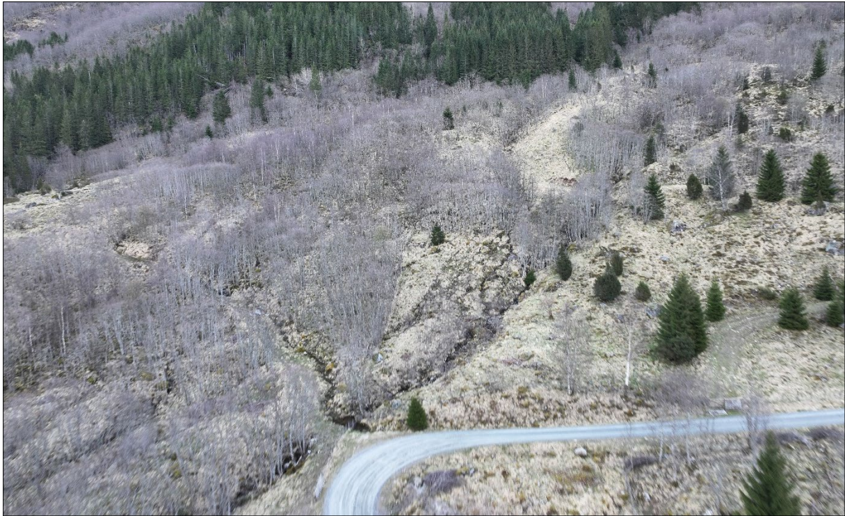
Figur 24: Det er fleire stadar i austleg del av påverknadsområdet der bekkeleia er lagt i røyr under veg/skogsveg/sti. Oppdemming ved desse punkta kan føre til at det blir samla vatn i snødekke som kan gje potensielle losneområde for sørpeskred.
