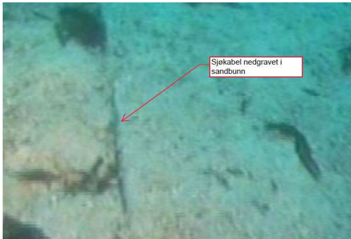
Figur 7 - Sjøkabel nedgravet/auret i sandbunnen og sjøkabel på havbunn
