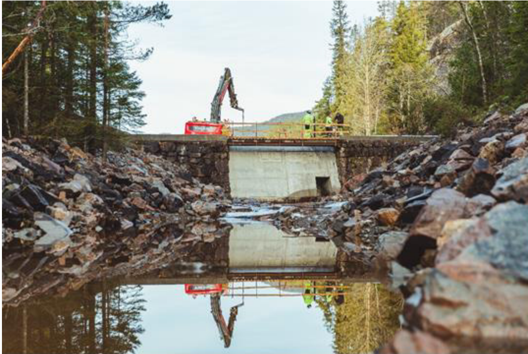
Figur 5: Dam Blæsa ved utløpet av Øvre Blæsa.
