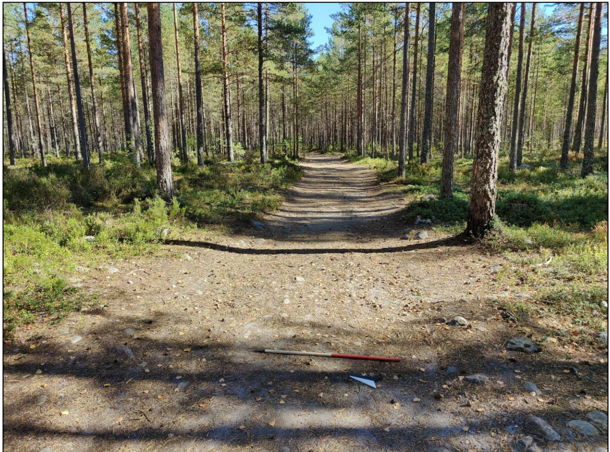
Figur 26. Sørlig ende av segmentet til Setesdalsvegen over Senum (ID 280984) ved masseuttaket
