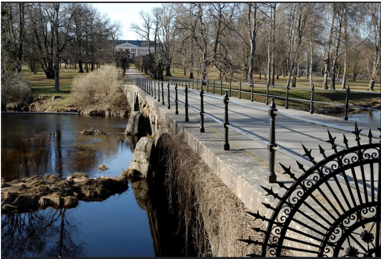
Fossum hovedgård med parkanlegg – bilde er tatt fra brua over Hoppestadelva i retning nord.
