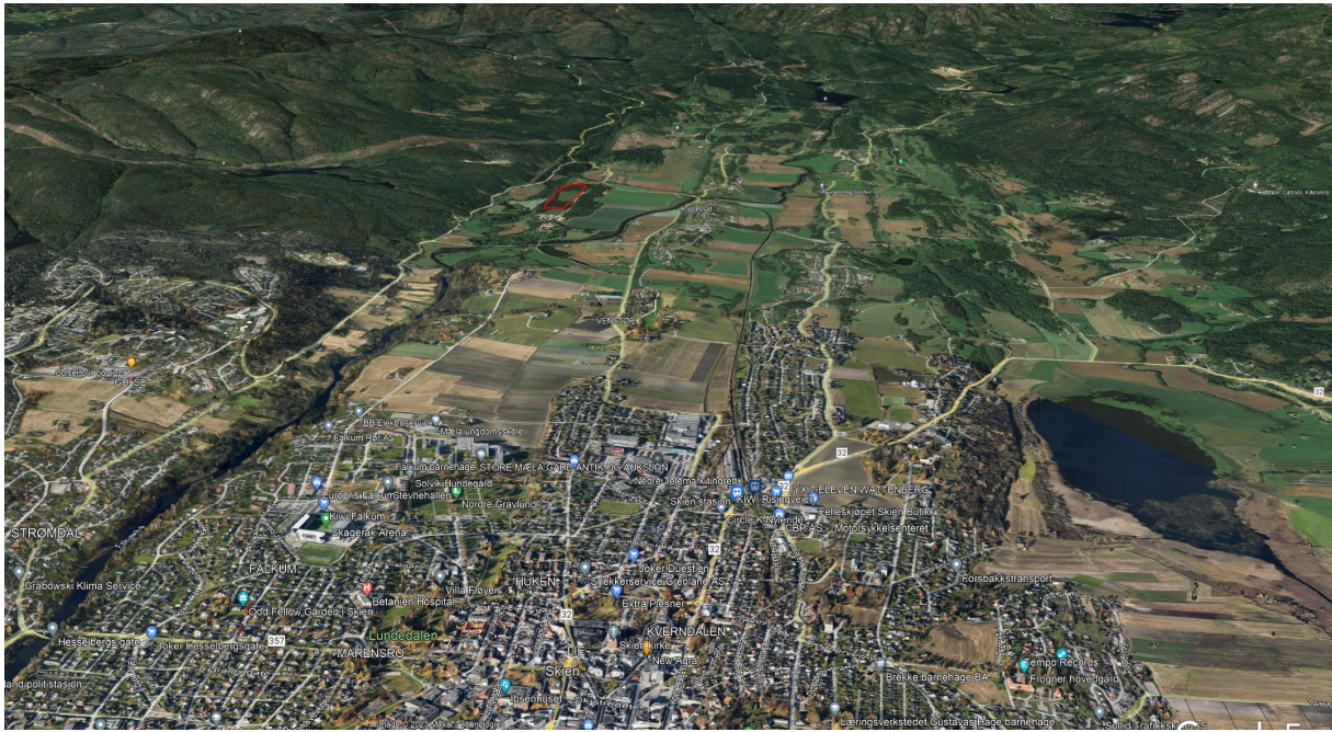
Figur 4-6 Bildet viser innlandssletta øst og nord for Skien sentrum, som gradvis går over i et dallandskap lengre nord. i øst og vest stiger terrenget til ås og fjellandskap. Lokalisering av planområdet er andtydet med rødt omriss (kilde: Google Earth Pro).
